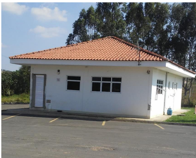
Figura 238 - Fachada do laboratório físico-químico - ETE Xyko.
