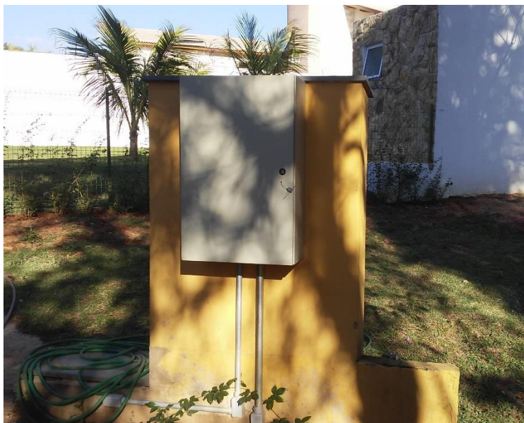
Figura 189 - Painel de comando EEE Portal I.
