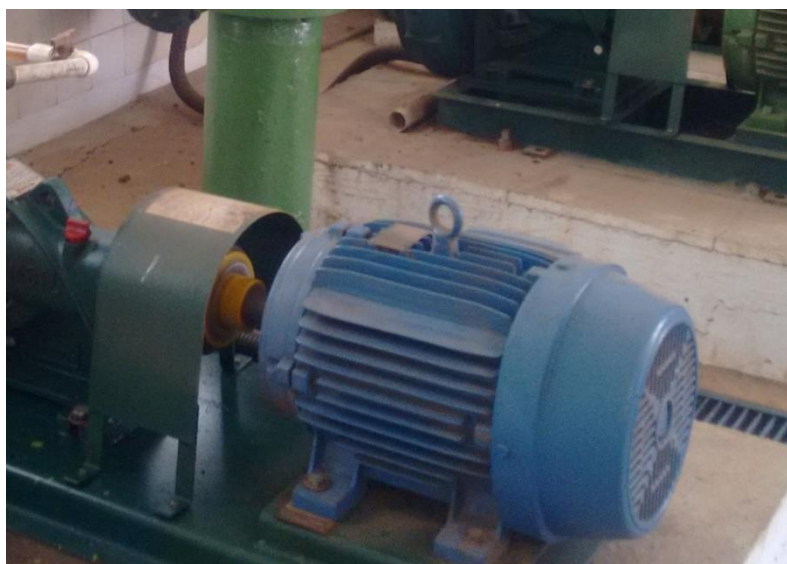
Figura 90 - Conjunto moto-bomba - EEAT Progresso.
