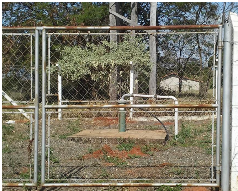
Figura 394 - Poço tubular profundo - Agrovila CAIC.
