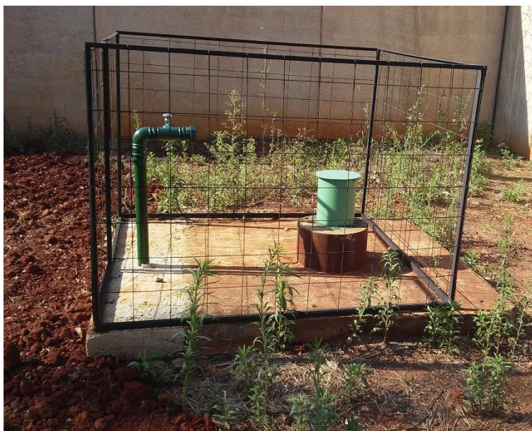
Figura 67 - Poço Portal dos Bandeirantes.
