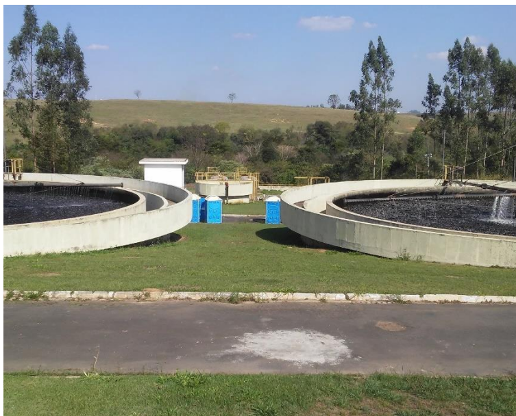
Figura 223 - Reatores de filtros biológicos aerados.
