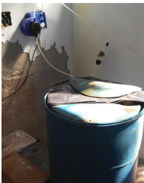
Figura 71 - Dosador de cloro - Poço Distrito Industrial Itaqui.
