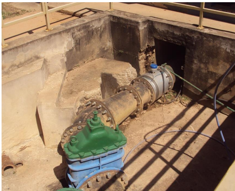
Figura 13 - Saída da adutora para ETA Central.
