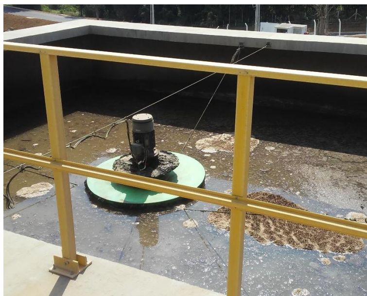
Figura 248 - Tanque de aeração.
