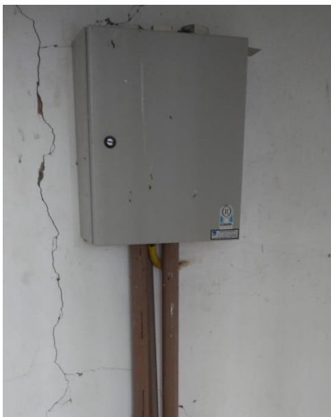
Figura 72 - Painele de controle - Poço Distrito Industrial Itaquí.
