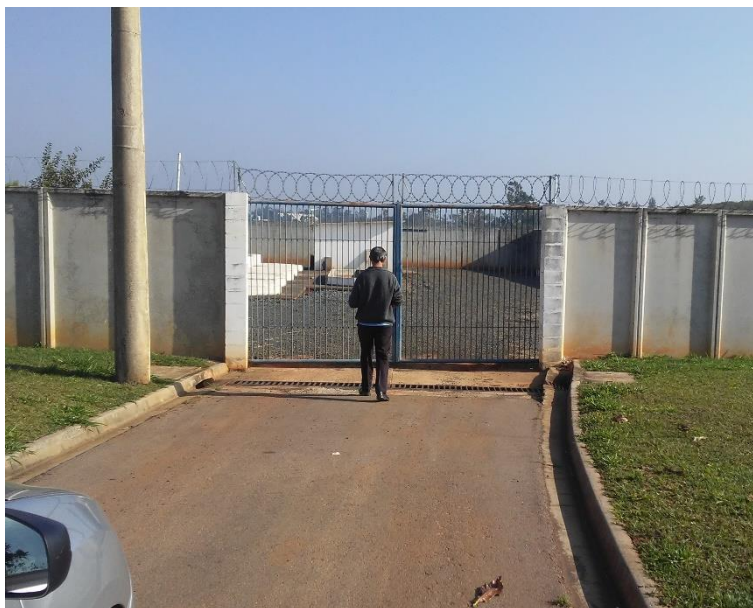
Figura 179 - Entrada EEE Portal dos Bandeirantes II.
