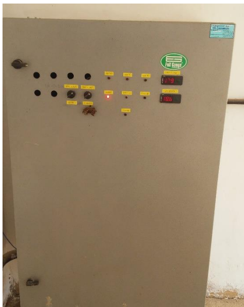
Figura 176 - Painel de comando EEE Olívio Barbosa.
