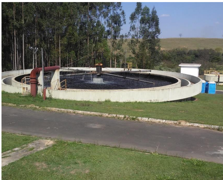
Figura 225 - Reator de filtro biológico aerado.
