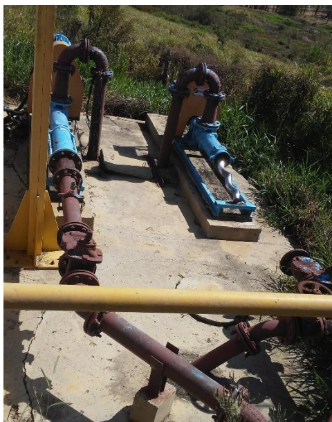
Figura 192 - Conjunto moto-bomba EEE São Carlos.
