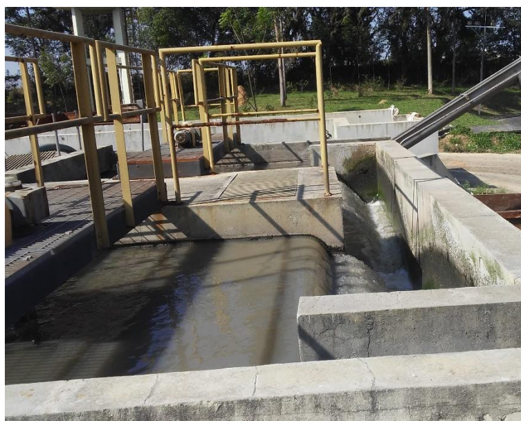
Figura 217 - Desarenador do tipo gravitacional.
