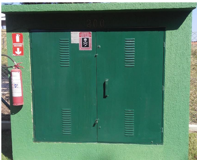
Figura 40 - Painel elétrico - Poço 2.
