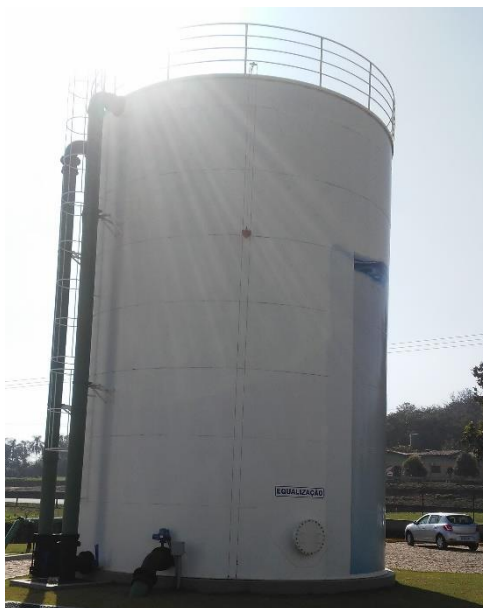
Figura 30 - Reservatório de equalização da água captada - 300 m 3 em aço carbono.
