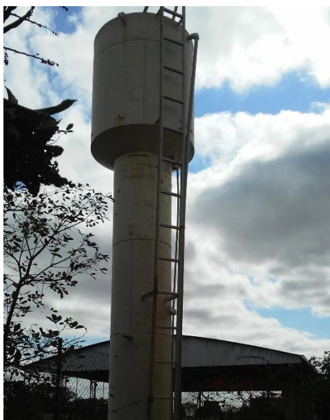
Figura 399 - Reservatório do posto de saúde - Agrovila CAIC.
