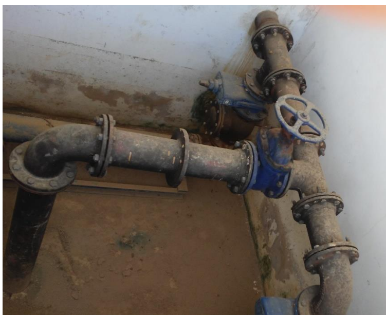
Figura 177 - Tubulação de chegada de esgoto na EEE Olívio Barbosa.
