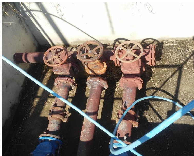
Figura 163 - Tubulação de entrada de esgoto na EEE 09.
