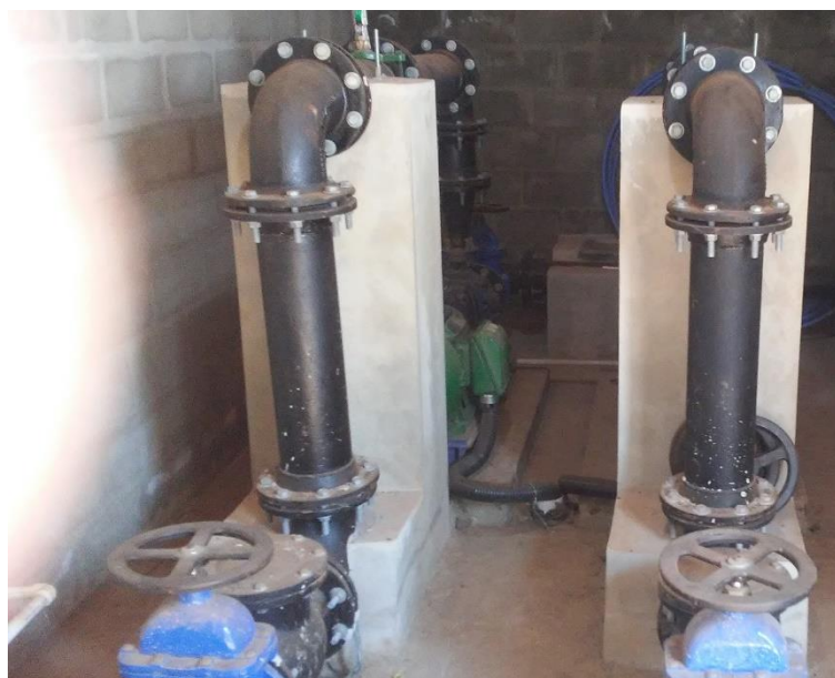
Figura 94 - Conjuntos moto-bomba - EEAT Distrito Industrial Rondon.
