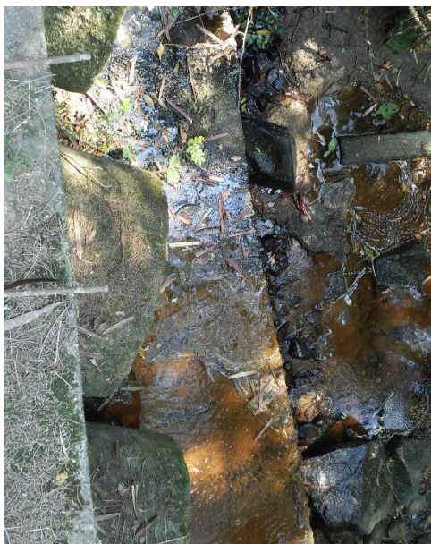
Figura 298 – Galeria de águas pluviais - Avenida Mário Covas - Altura nº 1.661.
