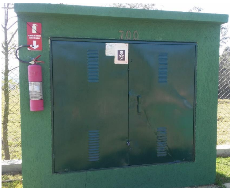
Figura 47 - Painel elétrico do Poço 3.
