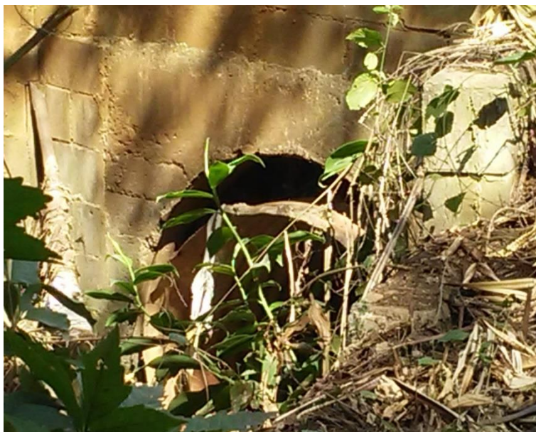
Figura 323 - Travessia na Avenida Mário Covas - Rotatória Gerson Angilieri.
