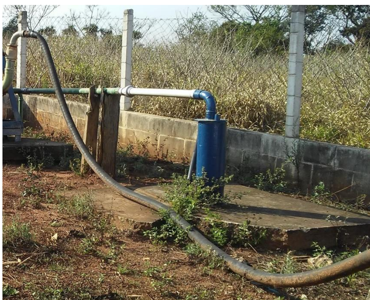
Figura 421 – Poço tubular profundo central – Bairro Cruz das Almas.
