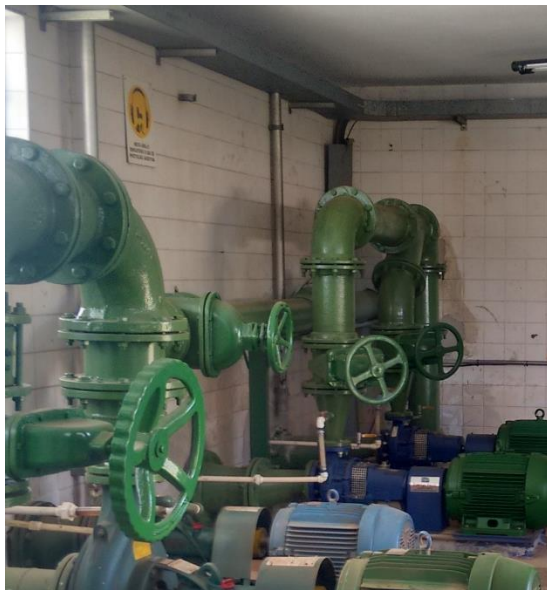
Figura 88 - Conjunto moto-bomba - EEAT Bepim.
