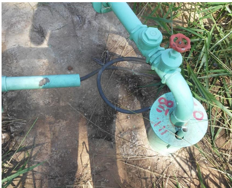
Figura 70 - Poço tubular profundo - Distrito Industrial Itaqui.
