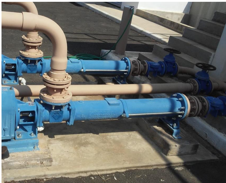
Figura 244 - Elevatória de esgoto para o sistema de tratamento.
