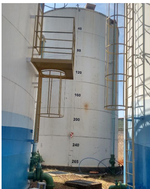
Figura 105 - Reservatório de 265 m 3 - lavagem de filtros.
