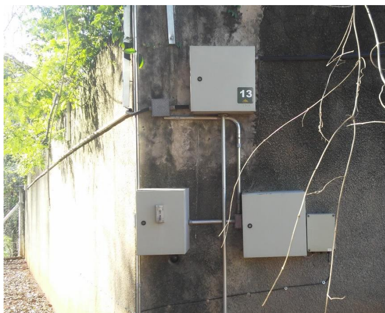
Figura 188 - Paineis elétricos EEE Portal I.
