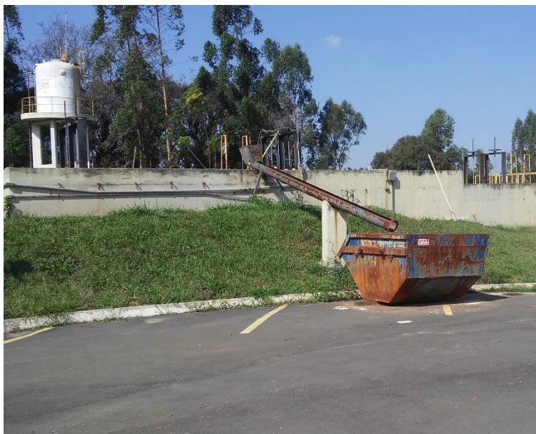
Figura 215 - Módulo de peneiramento.
