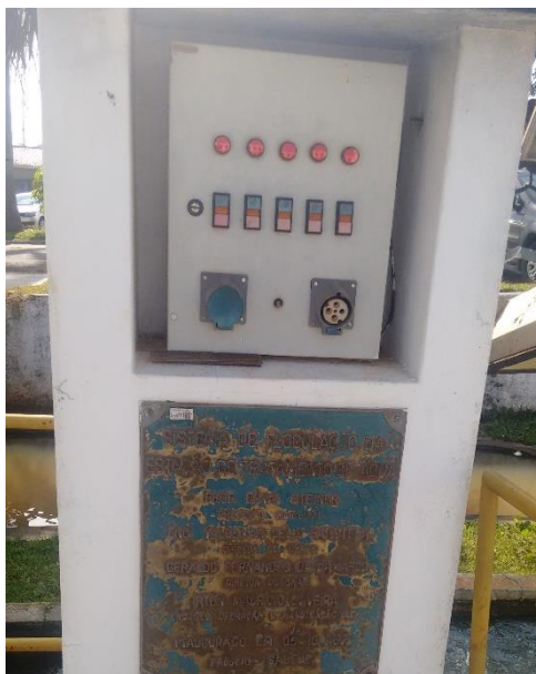
Figura 19 - Painel de comando dos floculadores.
