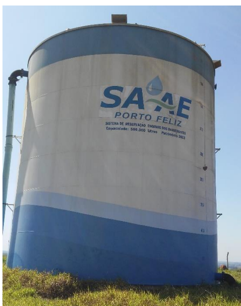
Figura 119 - Reservatório Engenho dos Bandeirantes - 500 m 3 .
