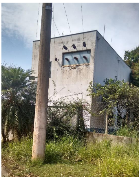
Figura 10 - Abrigo dos painéis elétricos de comando.
