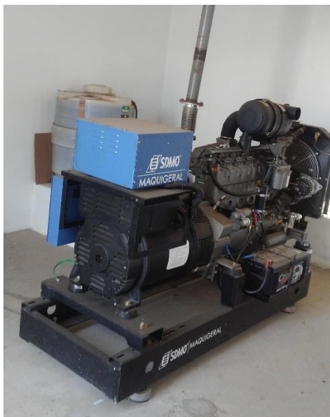
Figura 252 - Gerador de energia - ETE Soamim.
