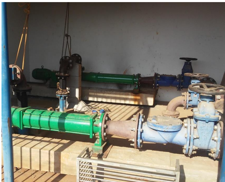
Figura 183 - Conjuntos moto-bomba EEE Portal dos Bandeirantes II.
