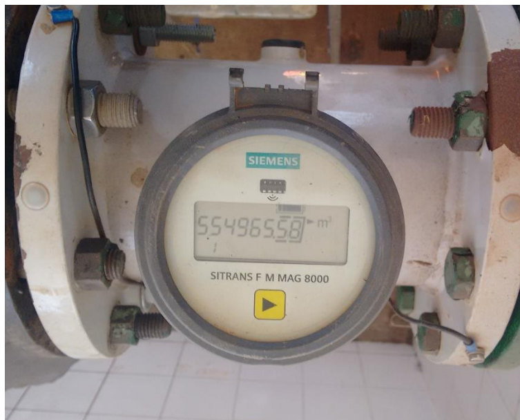
Figura 83 - Macromedidor - EEAT Popular Velha.
