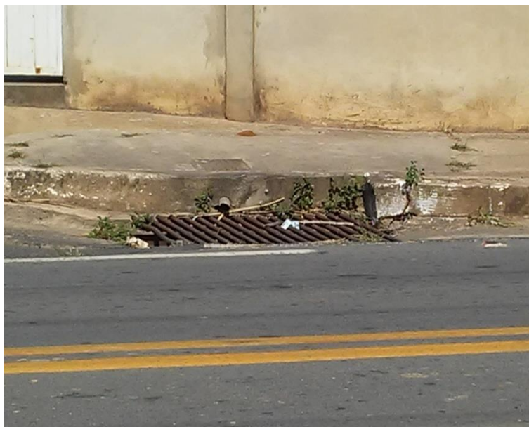
Figura 289 - Galeria Avenida Mário Covas - Altura nº 1.059.
