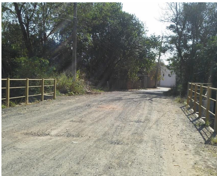
Figura 327 - Travessia no Bairro da Ponte.
