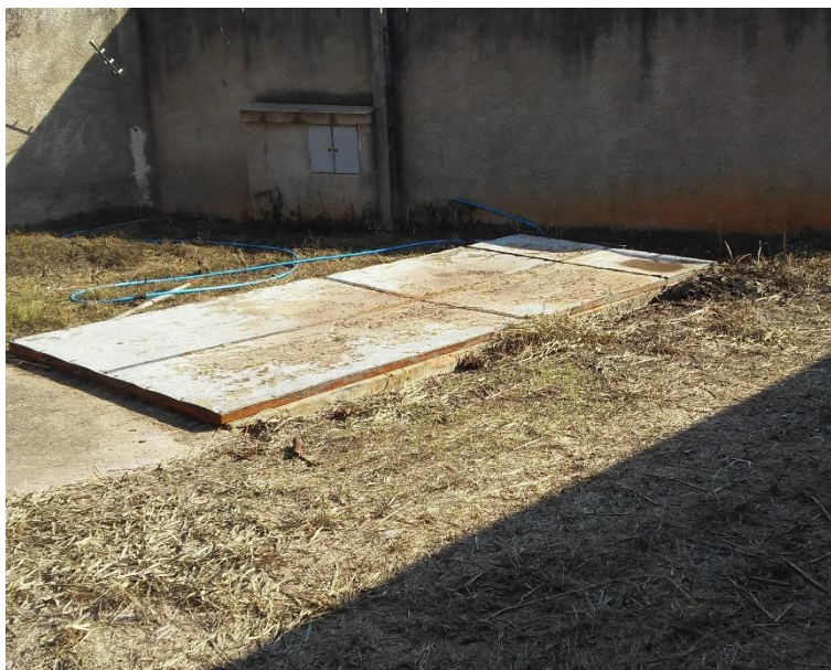
Figura 138 - Tampa do gradeamento.
