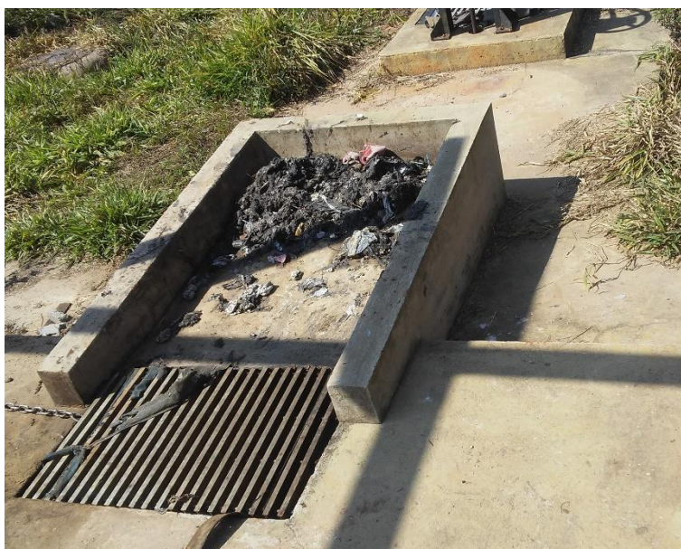
Figura 154 - Secagem de lodo - EEE 05.
