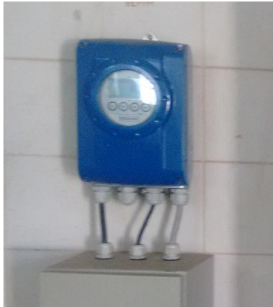
Figura 87 - Visor do macromedidor - EEAT Bepim.
