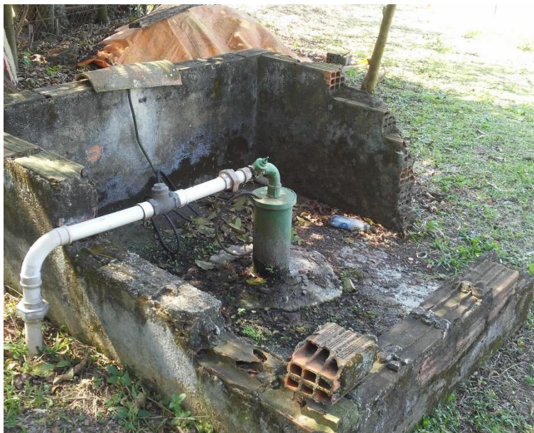
Figura 383 - Poço tubular profundo - Parque dos Bello.
