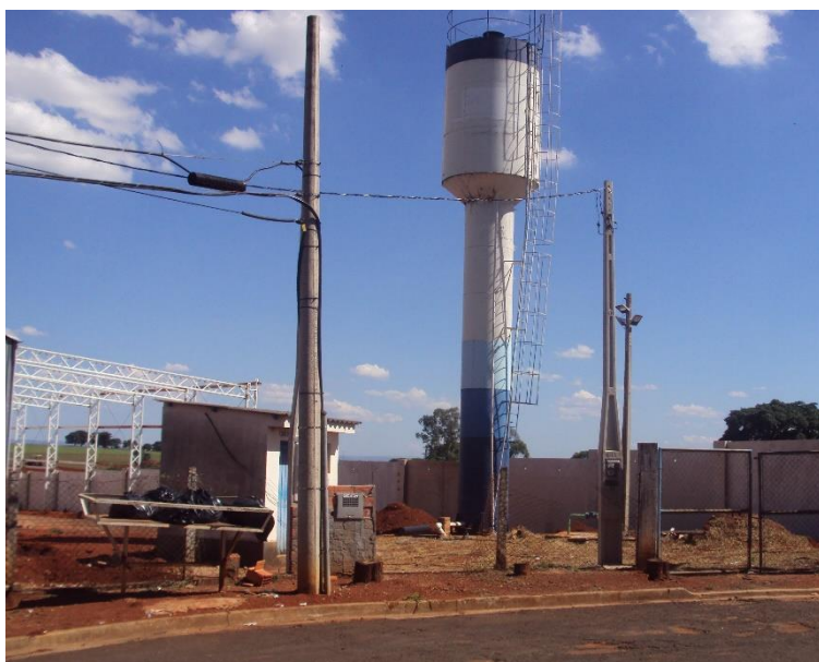
Figura 112 - Reservatório de 30 m 3 .
