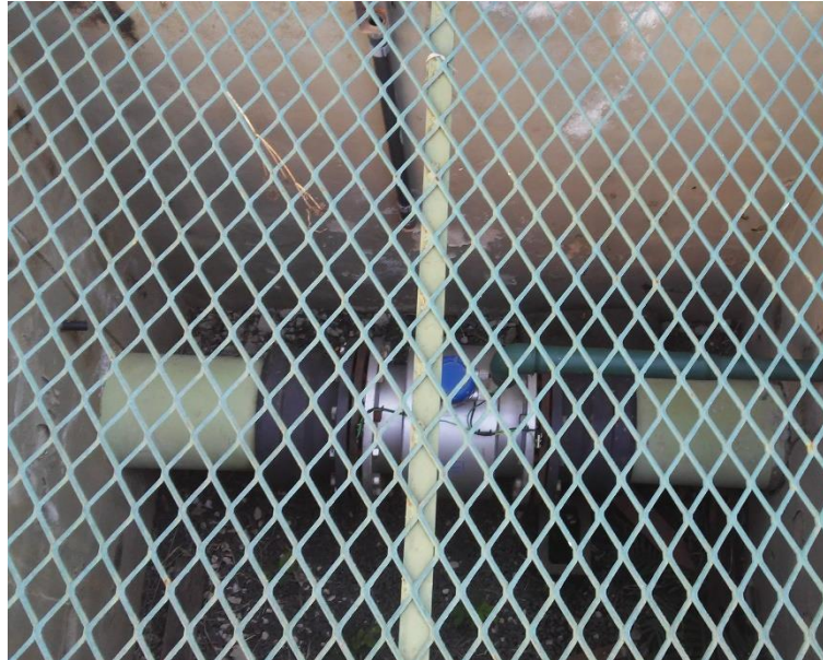
Figura 107 - Macromedidor Sistema de Reservação Palmital.
