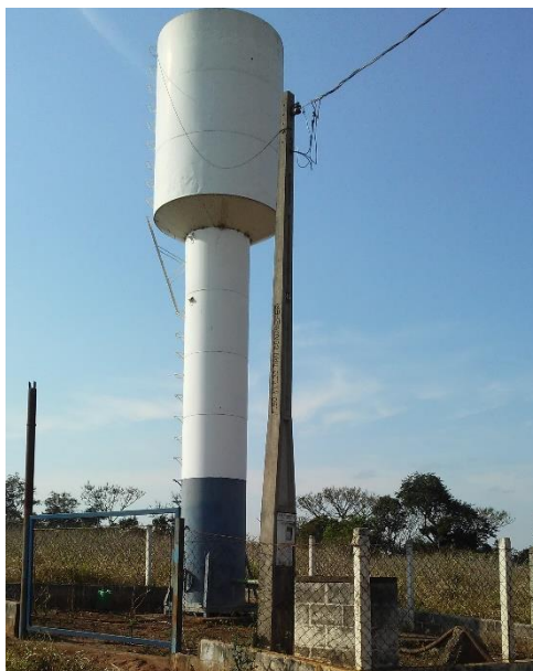
Figura 422 – Reservatório central – Bairro Cruz das Almas.
