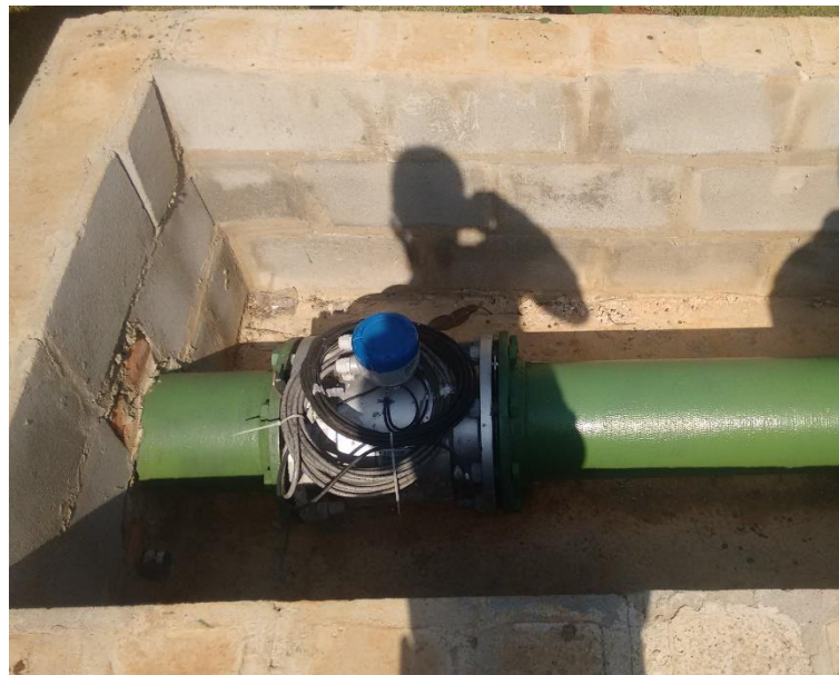
Figura 85 - Macromedidor - EEAT Popular Nova.
