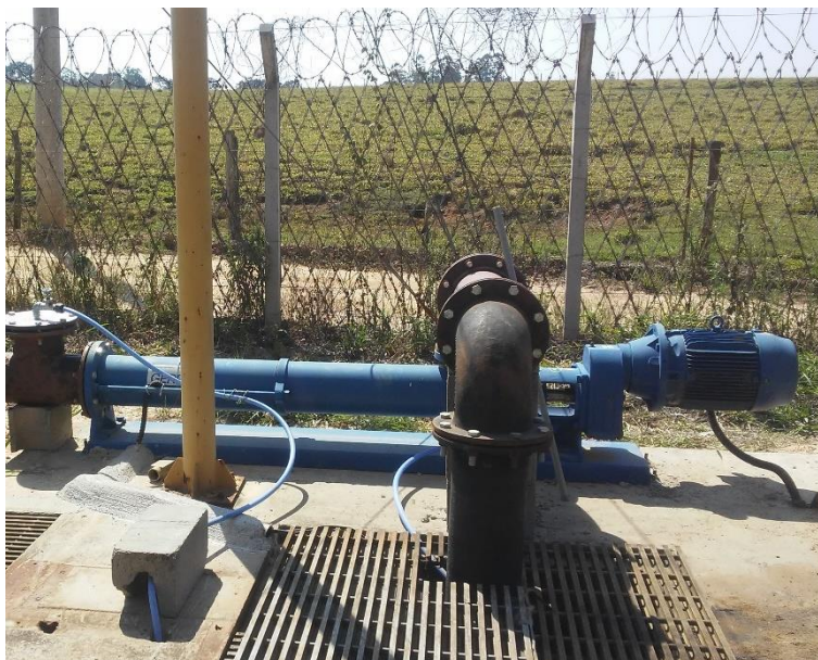
Figura 155 - Conjunto moto-bomba - EEE 05.
