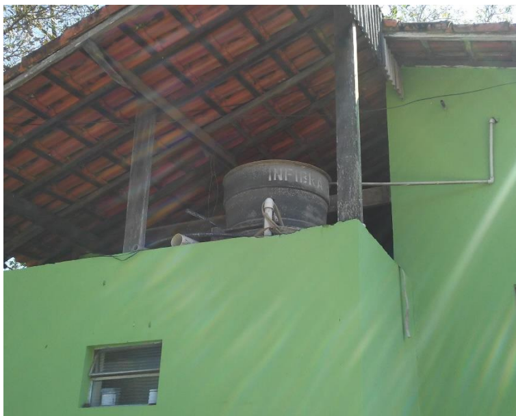
Figura 385 - Caixa d'água - Parque dos Bello.
