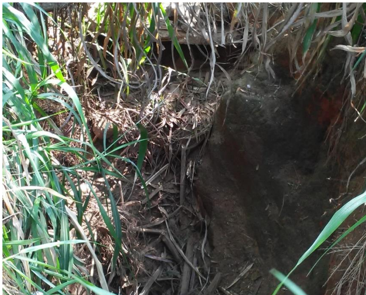
Figura 292 - Erosão de solo devido águas pluviais - Avenida Mário Covas - Altura nº 1.059.
