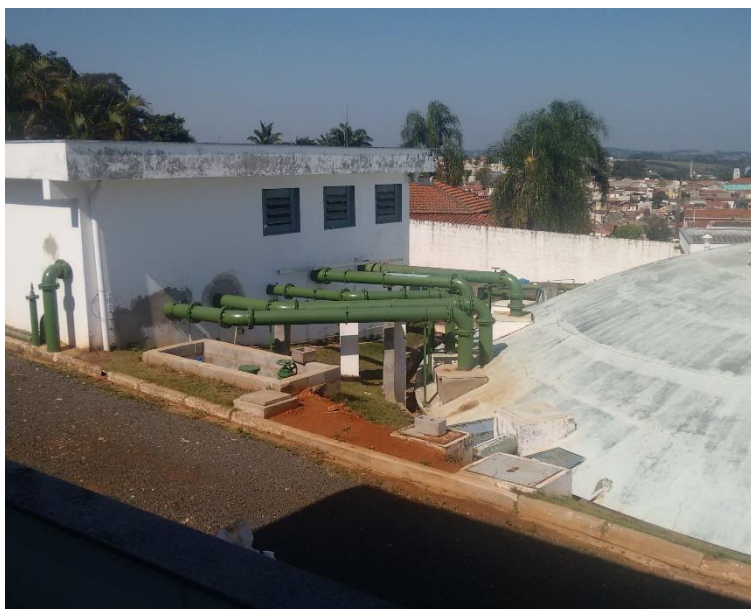
Figura 103 - Vista lateral do Reservatório ETA Central.
