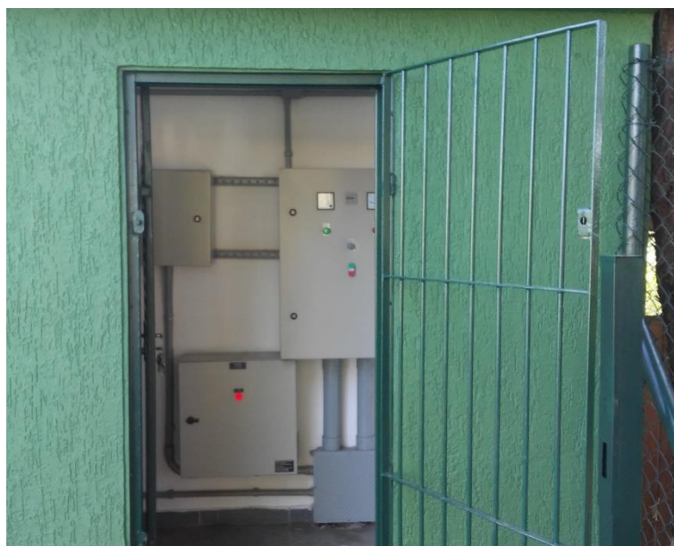
Figura 42 - Painel de comando do Poço 2.
