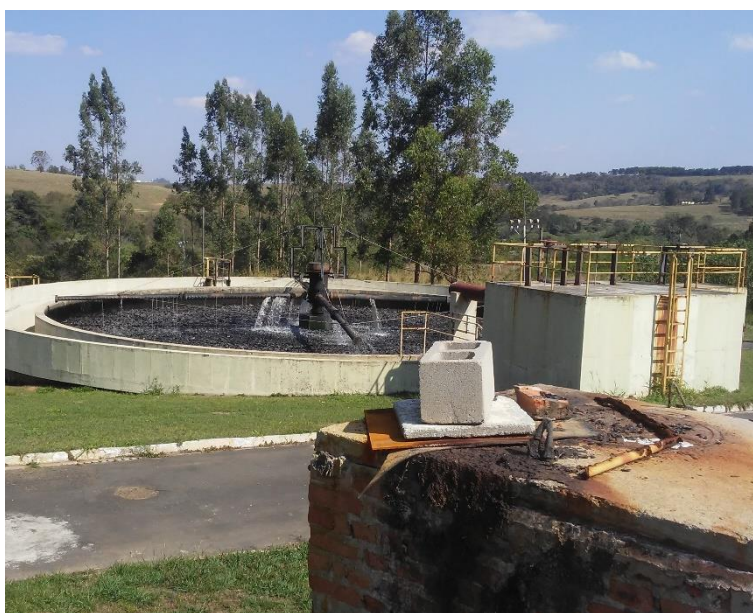
Figura 224 - Reator de filtro biológico aerado.
