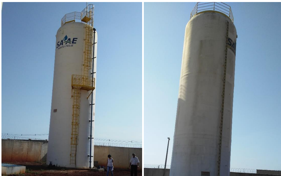
Figura 110 - Reservatórios Portal dos Bandeirantes 300 m 3 cada.
