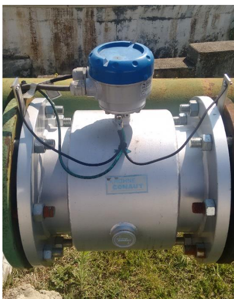
Figura 91 - Macromedidor - EEAT Vila América Elevado.
