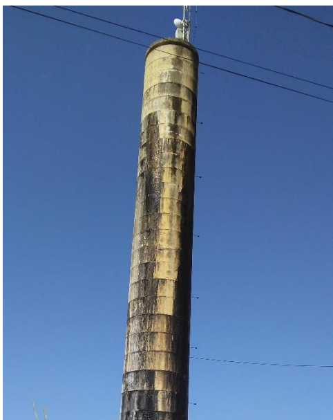
Figura 130 - Reservatório Vista Alegre - 30 m 3 .
