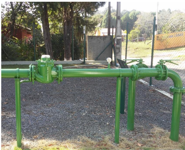
Figura 41 - Tubulação adutora do Poço 2, com macromedidor.
