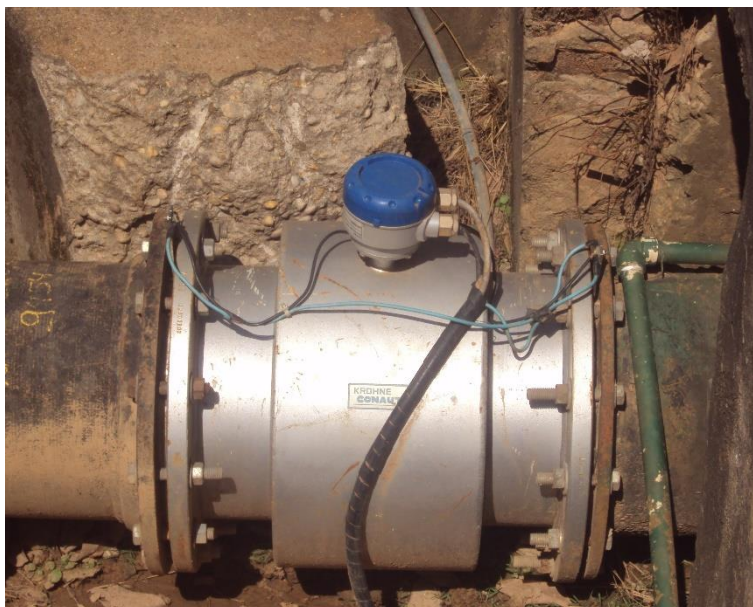
Figura 14 - Macromedidor na saída.
