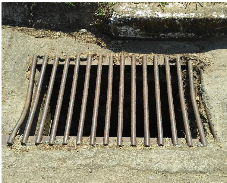
Figura 308 – Boca de lobo construída pelo SAAE - Rua Joaquim Sampaio Sobrinho.
