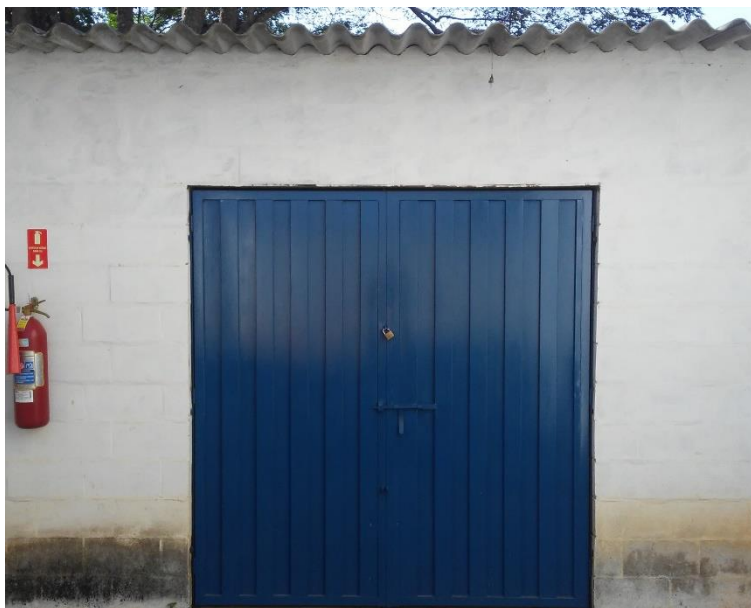
Figura 97 - Abrigo da EEAT Popular.
