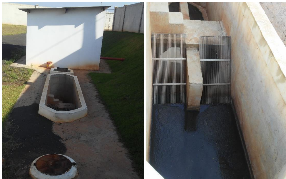
Figura 168 - Gradeamento EEE Flamboyant.
