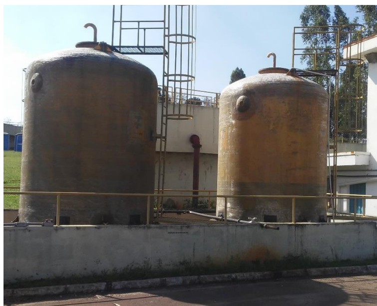
Figura 227 - Reservatórios de armazenamento de hipoclorito de sódio.
