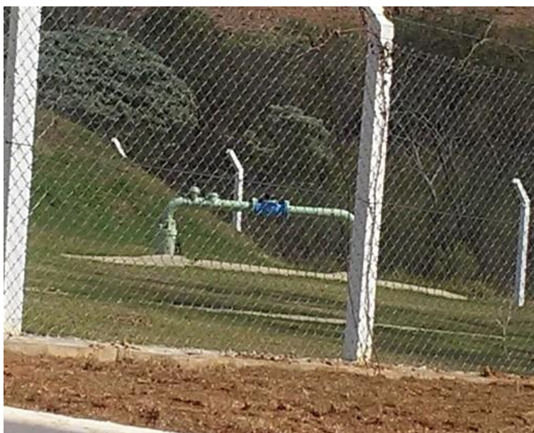
Figura 243 - Macromedidor de esgoto bruto - ETE Soamim.
