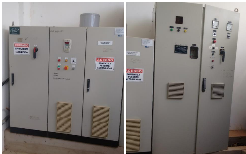
Figura 11 - Paineis de comando (a).
