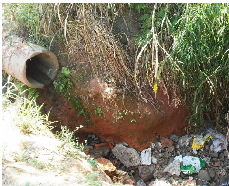
Figura 295 – Erosão do solo devido encaminhamento de águas pluviais e descarte irregular de resíduos sólidos - Avenida Mário Covas - Altura nº 1.661.
