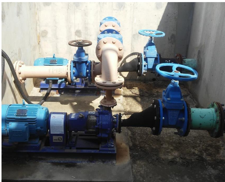
Figura 253 - Bombas centrífugas.
