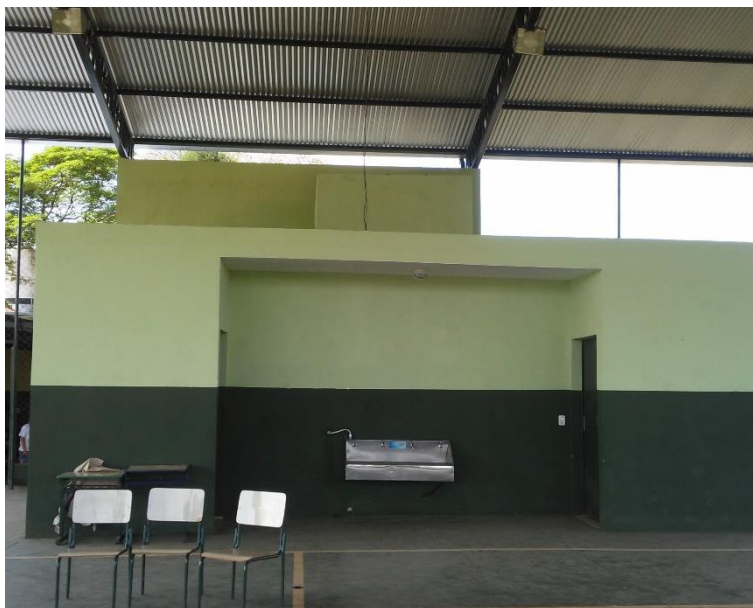
Figura 402 - Caixa d'Água da escola - Agrovila CAIC.
