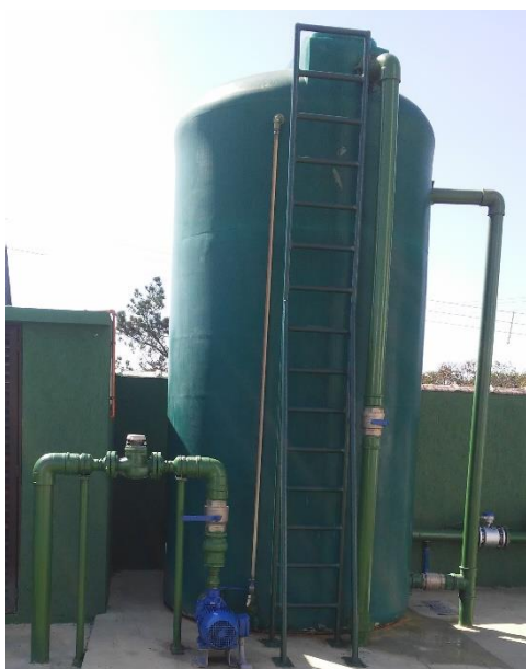
Figura 66 - Reservatório de retrolavagem dos filtros do Poço 6.
