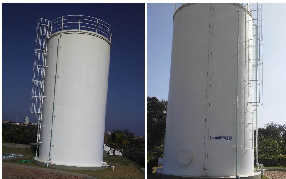
Figura 33 - Reservatório de retrolavagem dos filtros - 120 m 3 em aço carbono.
