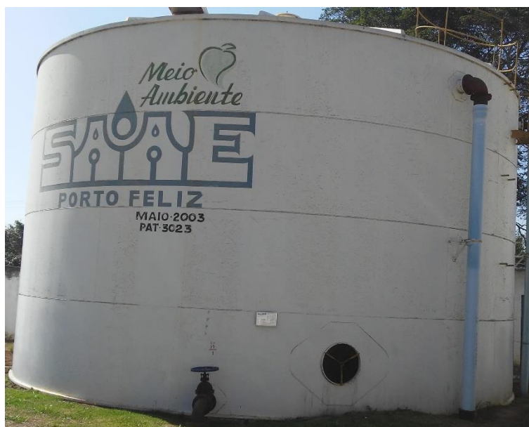
Figura 122 - Reservatório 500 m 3 .
