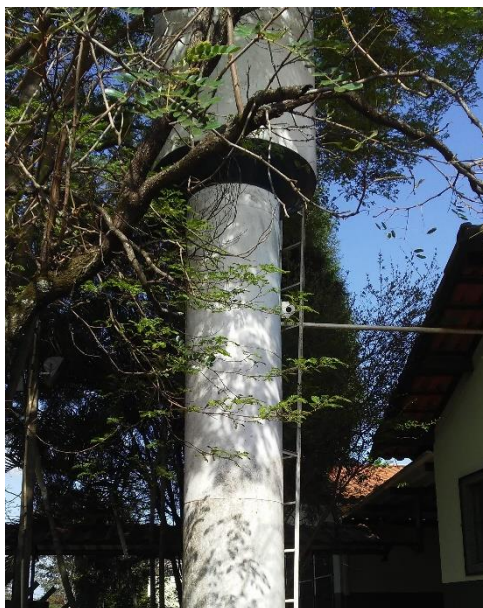
Figura 400 - Reservatório da escola - Agrovila CAIC.
