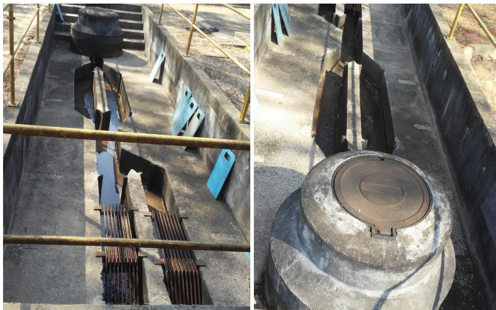
Figura 211 - Calha Parshall e Terminal de Inspeção e Limpeza - Fossa Filtro Distrito Industrial Itaquí.
