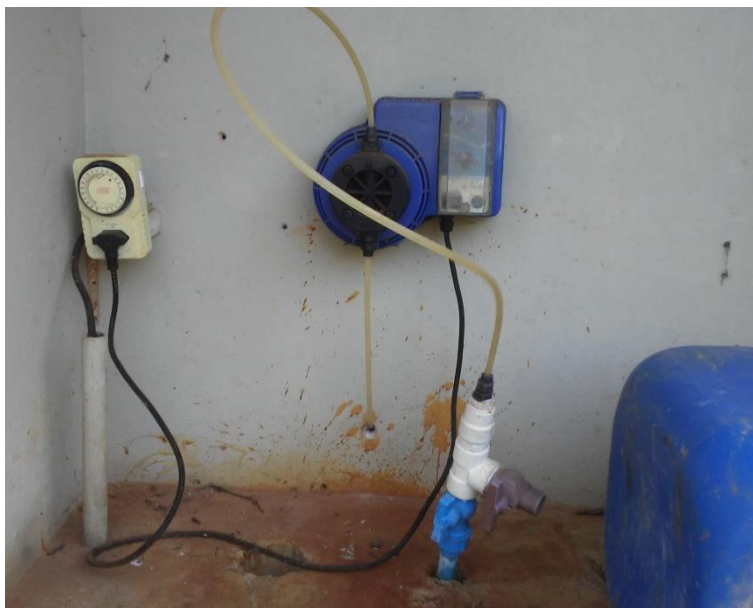
Figura 147 - Dosador de nitrato de amônia.
