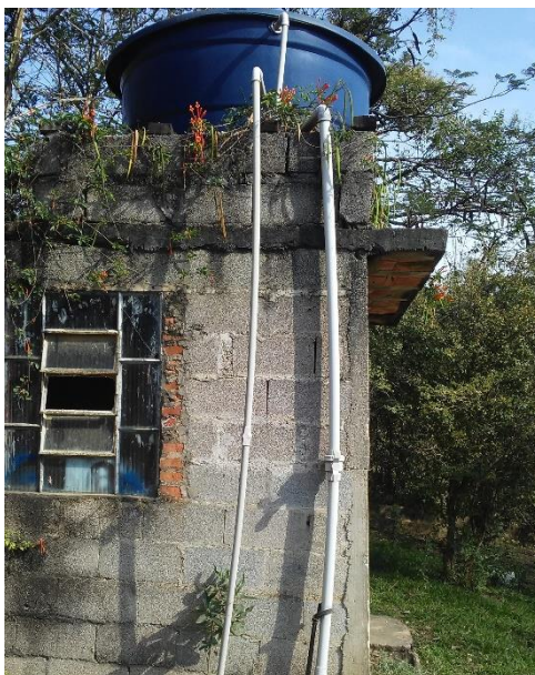
Figura 413 - Caixa d'água individual - São Francisco.
