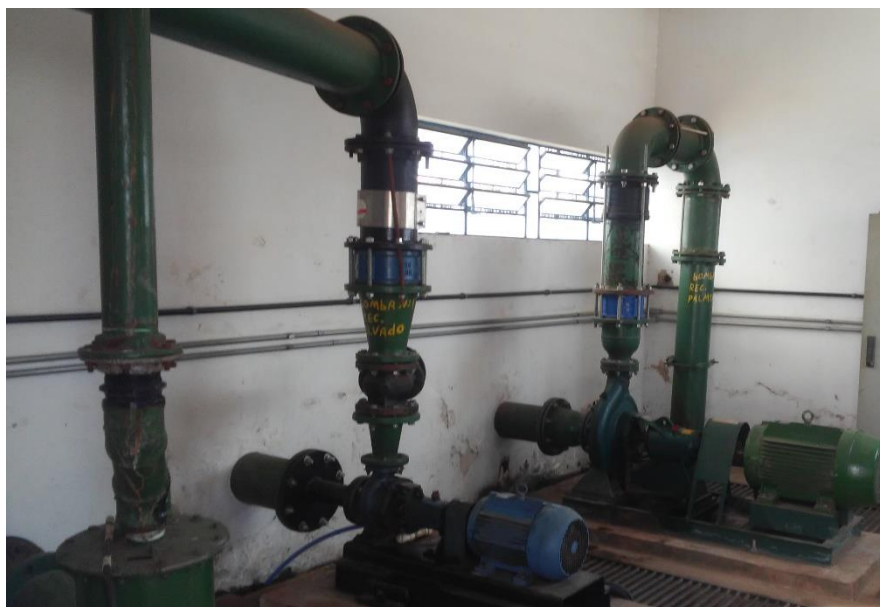
Figura 99 - Conjuntos moto - bomba - EEAT Vila América.
