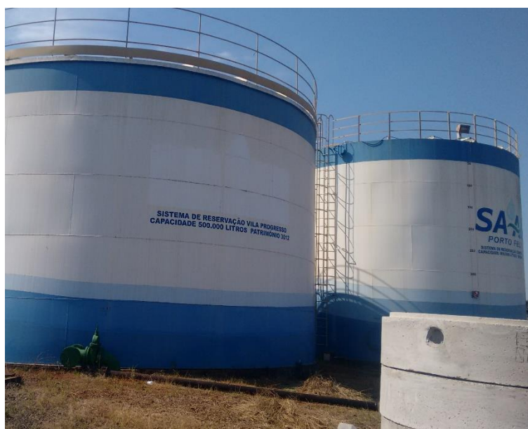
Figura 104 - Reservatórios de 500 m 3 cada.
