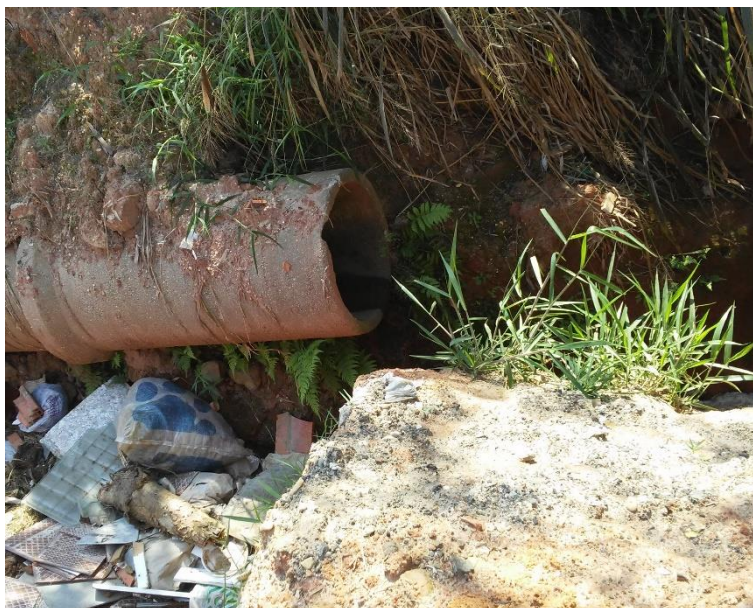
Figura 294 – Tubulação de microdrenagem - Avenida Mário Covas - Altura nº 1.661.
