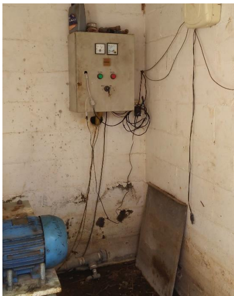
Figura 141 - Pannel de comando - EEE Jardim Brasil.
