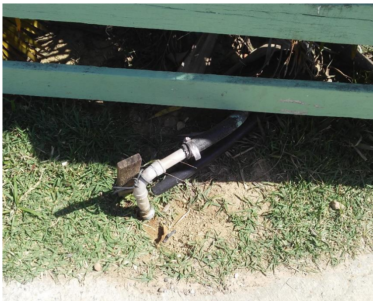
Figura 390 - Ligação de água - poço central no Valter de Lara.
