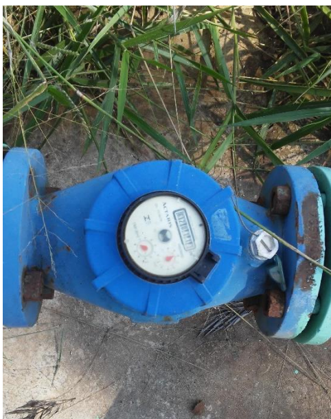
Figura 73 - Macromedidor - Poço Distrito Industrial Itaquí.
