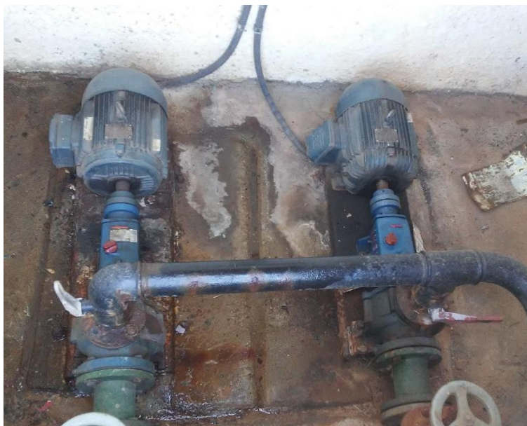
Figura 96 - Conjuntos moto-bomba - EEAT Campo Santo.
