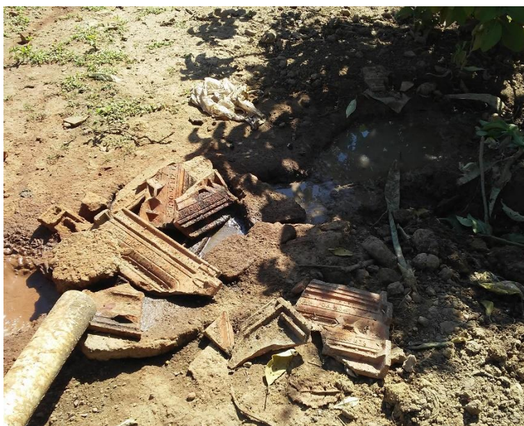
Figura 380 - Água servida percolando pelo solo - Fazenda Campo Grande.
