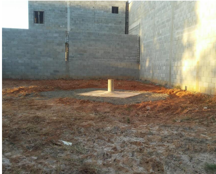
Figura 77 - Poço São Francisco Cemitério.
