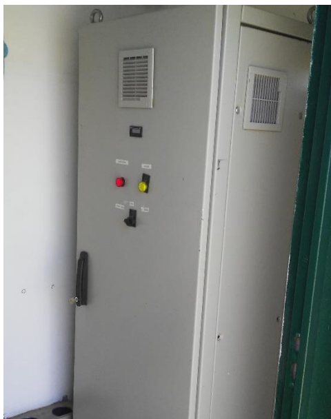
Figura 48 - Painel de comando do Poço 3.
