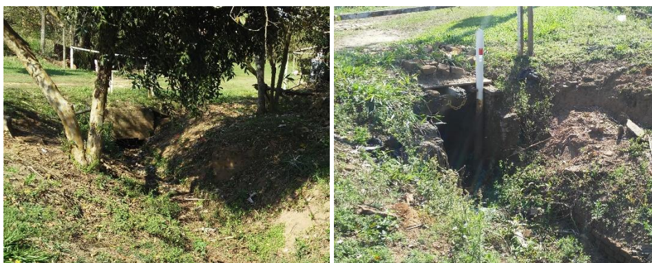
Figura 382 - Erosão do solo devido águas pluviais - Fazenda Campo Grande.
