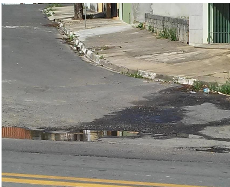
Figura 290 - Extravasamento de água em galeria - Avenida Mário Covas - Altura nº 1.059.
