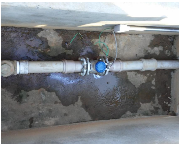
Figura 186 - Macromedidor EEE Portal I.
