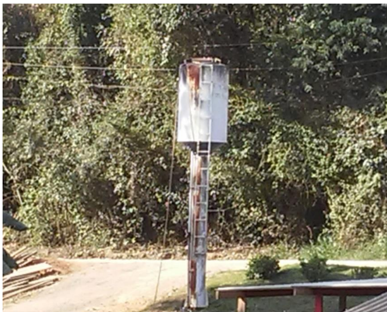
Figura 410 - Reservatório individual - Santo Augusto.
