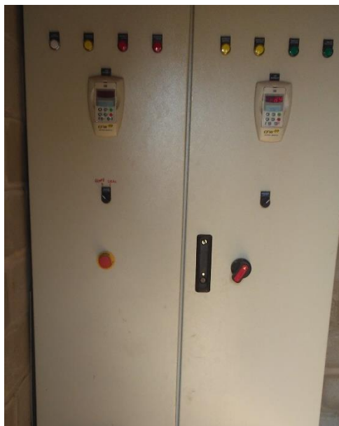
Figura 95 - Painel de controle - EEAT Distrito Industrial Rondon.
