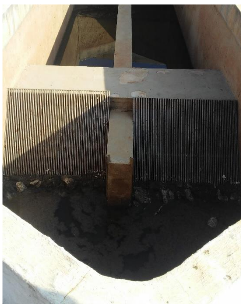
Figura 182 - Gradeamento EEE Portal dos Bandeirantes II.
