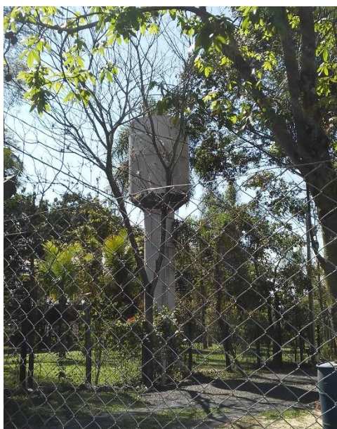
Figura 384 – Reservatório de água - Parque dos Bello.
