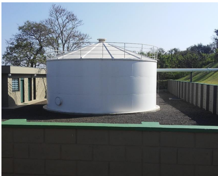
Figura 34 - Reservatório de água - 200 m 3 em aço carbono.
