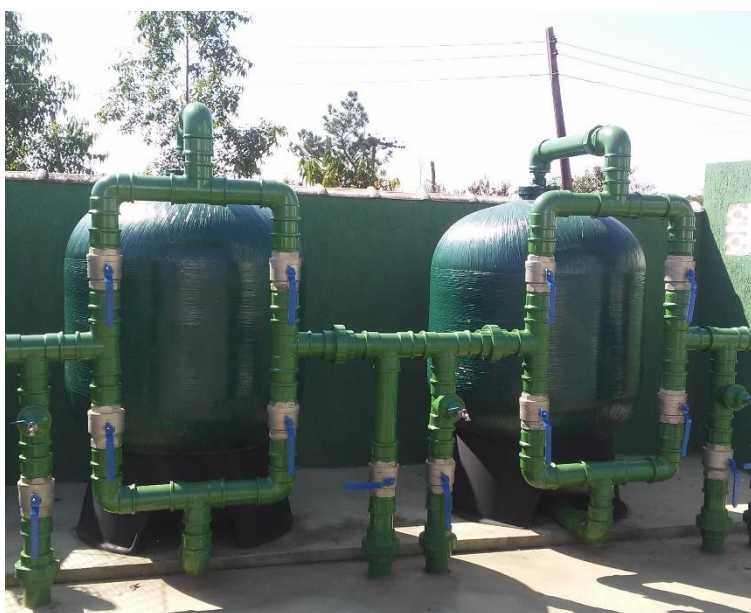
Figura 60 - Sistema de filtragem compacto do Poço 6.
