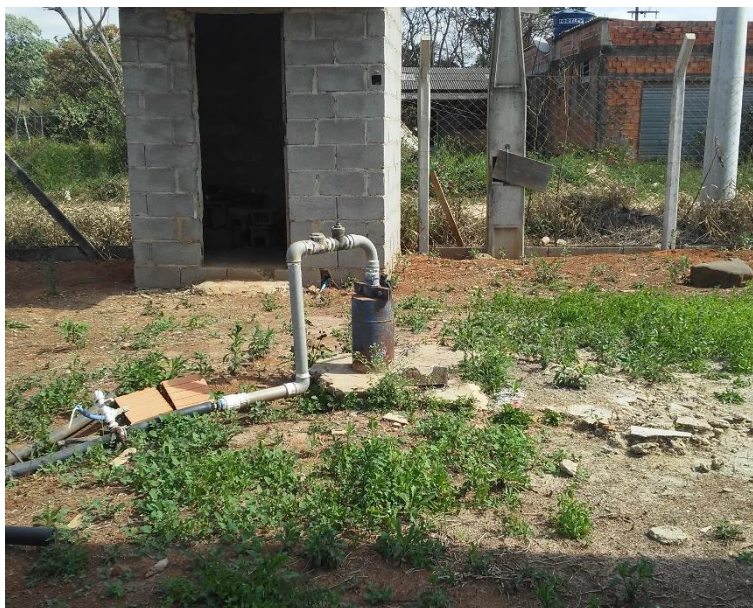
Figura 396 - Poço tubular profundo - Agrovila CAIC.
