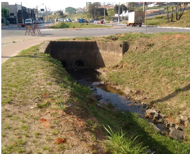
Figura 315 - Travessia – Avenida Doutor Antônio Pires de Almeida.
