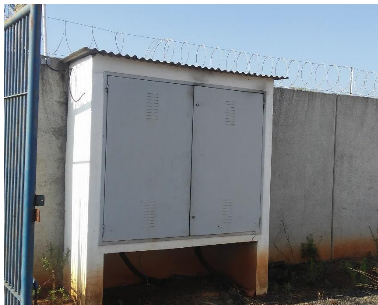
Figura 181 - Painel elétrico EEE Portal dos Bandeirantes II.
