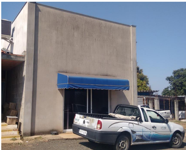
Figura 133 - Fachada do laboratório de testes de hidrômetros.
