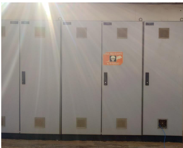
Figura 197 - Painéis elétricos EEE 03.
