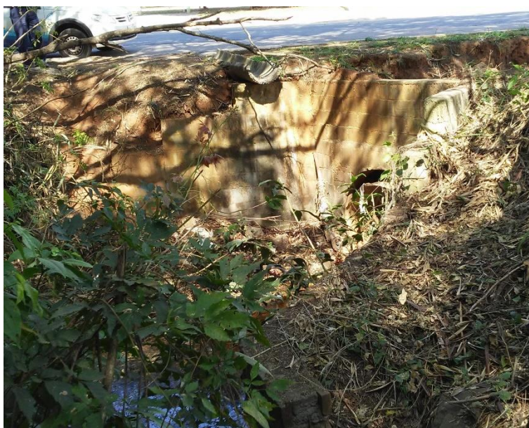
Figura 322 - Travessia na Avenida Mário Covas - Rotatória Gerson Angilieri.
