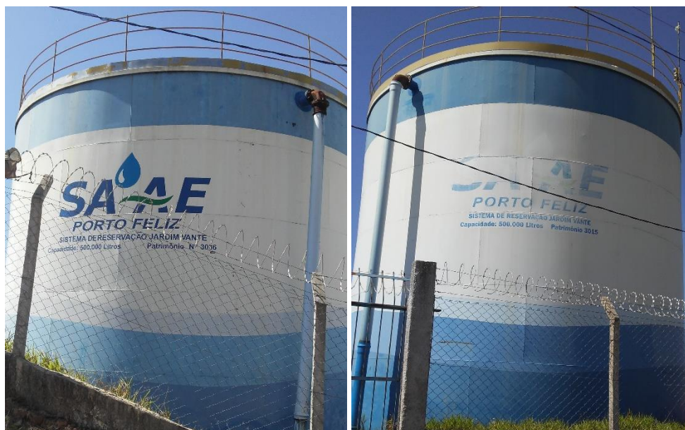
Figura 118 - Reservatórios 500 m 3 cada.
