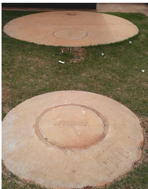
Figura 403 – Fossa séptica - Agrovila CAIC.
