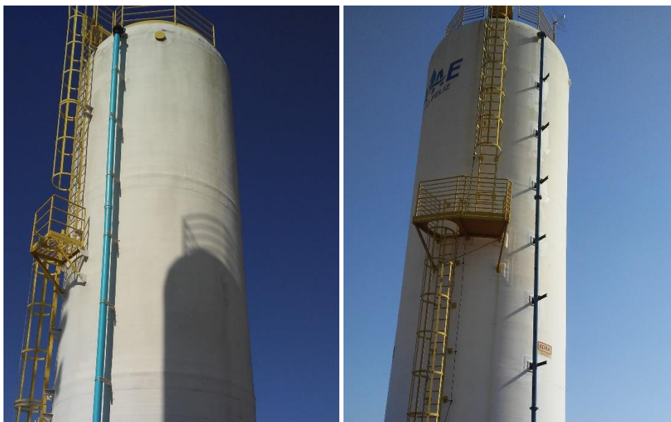
Figura 109 - Reservatórios Portal dos Bandeirantes 300 m 3 cada.
