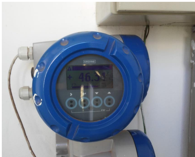
Figura 65 - Leitor de macromedição do Poço 6.
