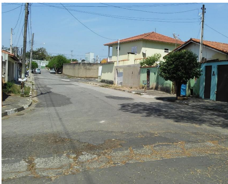
Figura 309 - Trecho da Rua Joaquim Sampaio Sobrinho com rede de microdrenagem remendada.
