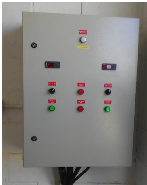
Figura 193 - Painel de comando EEE São Carlos.
