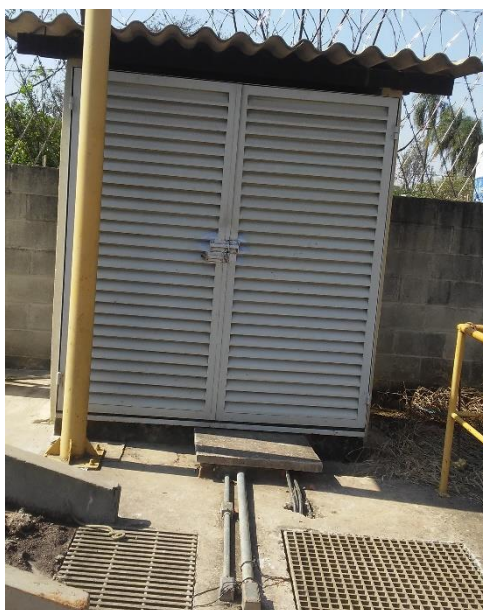
Figura 164 - Abrigo de painéis de comando – EEE 09.
