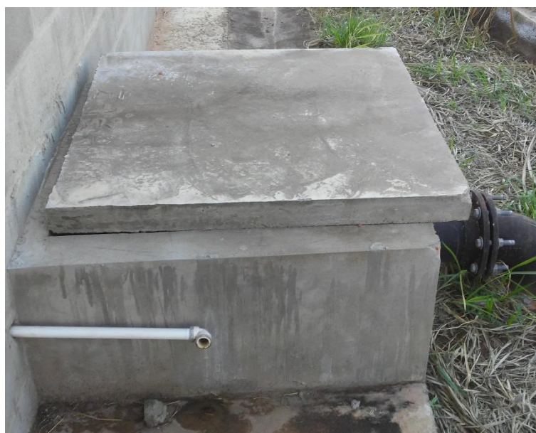
Figura 114 - Abrigo do macromedidor.
