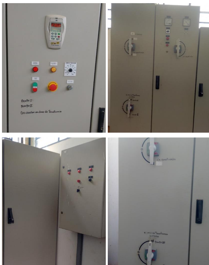
Figura 12 - Paineis elétricos (b).
