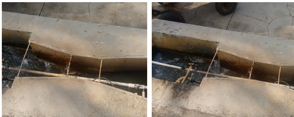
Figura 17 - Calha Parshall.
