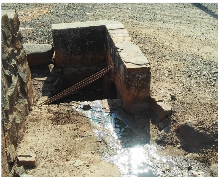
Figura 432 – Valeta de drenagem - Fazenda Jupira.
