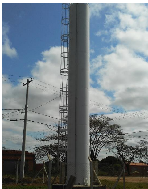
Figura 397 - Reservatório - Agrovila CAIC.
