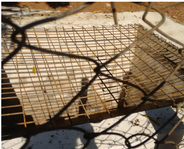
Figura 312 - Construção de sistema de microdrenagem no Jardim Santa Rosa.
