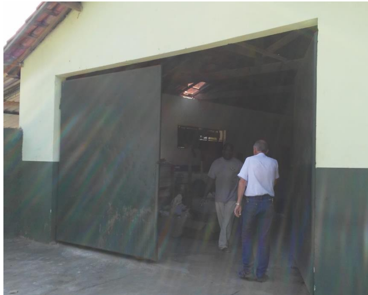
Figura 274 - Entrada do ecoponto.
