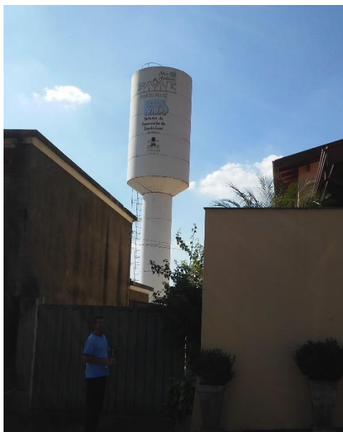
Figura 125 - Reservatório Santa Casa - 50 m 3 .
