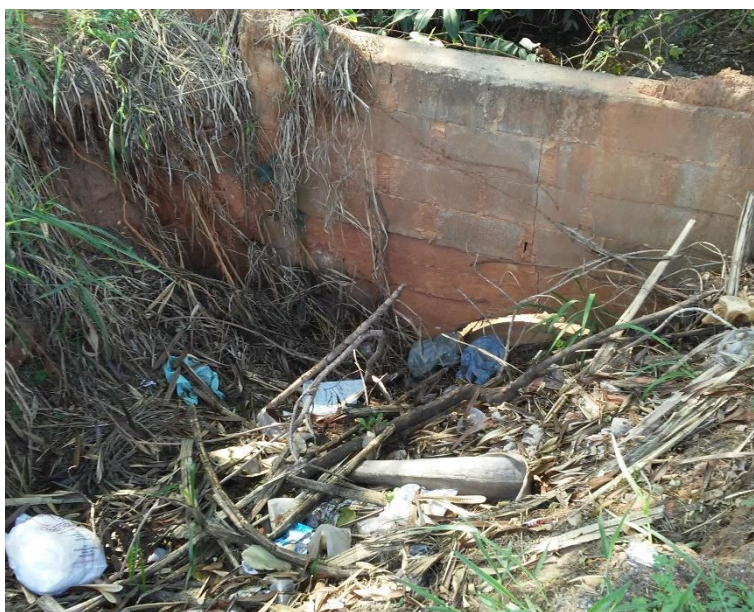
Figura 324 - Travessia na Avenida Mário Covas - Rotatória Gerson Angilieri.
