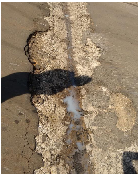
Figura 305 – Valeta para encaminhamento de águas pluviais na Rua Cabreúva.
