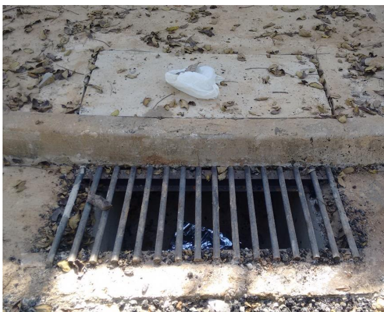
Figura 311 - Construção de sistema de microdrenagem no Jardim Santa Rosa.
