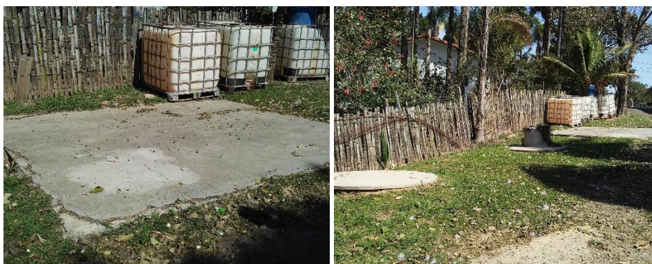
Figura 386 - Fossa séptica - Parque dos Bello.
