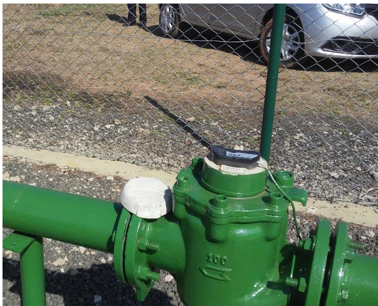
Figura 46 - Macromedidor do Poço 3.
