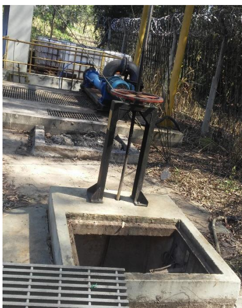
Figura 149 - Conjunto moto-bomba EEE 04.
