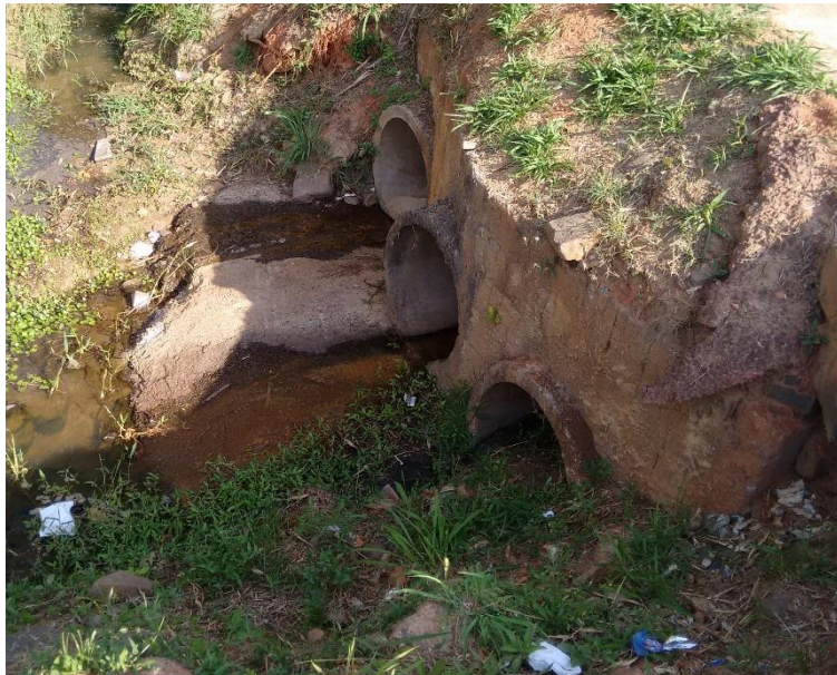
Figura 316 - Travessia – Avenida Doutor Antônio Pires de Almeida.
