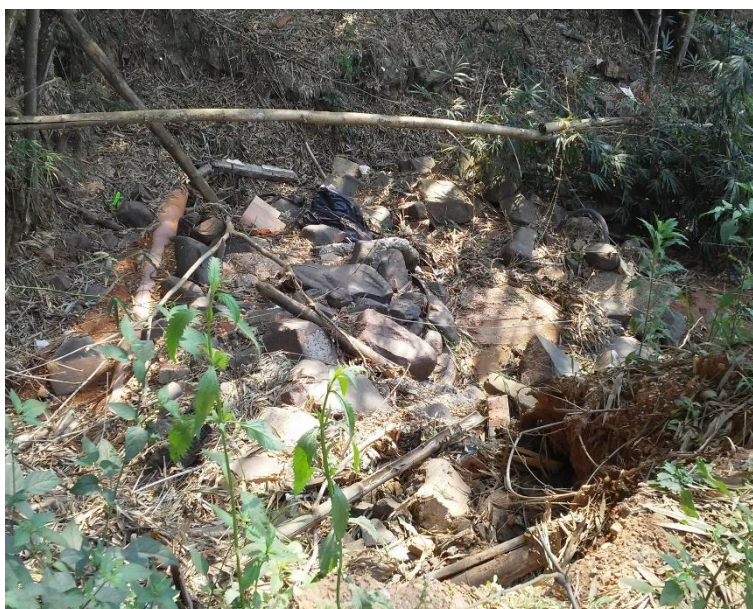
Figura 301 – Abertura de vala devido às águas pluviais - em frente à Captação no Ribeirão Avecuia.
