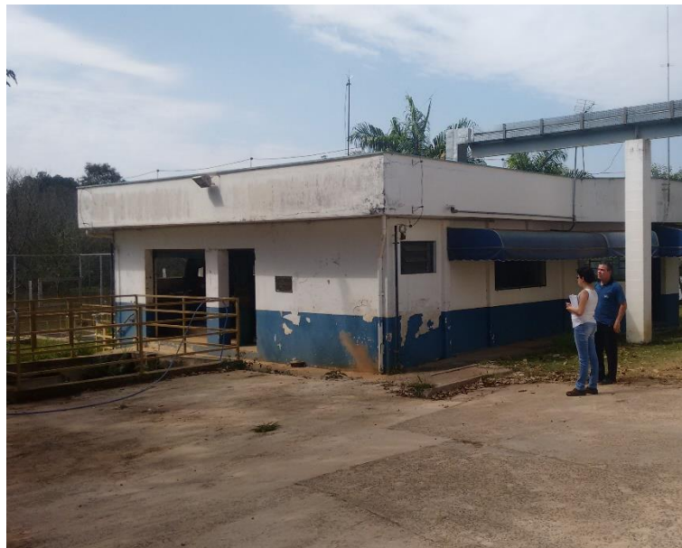
Figura 8 - Casa de Bombas.
