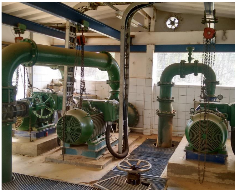
Figura 9 - Conjuntos moto-bomba.
