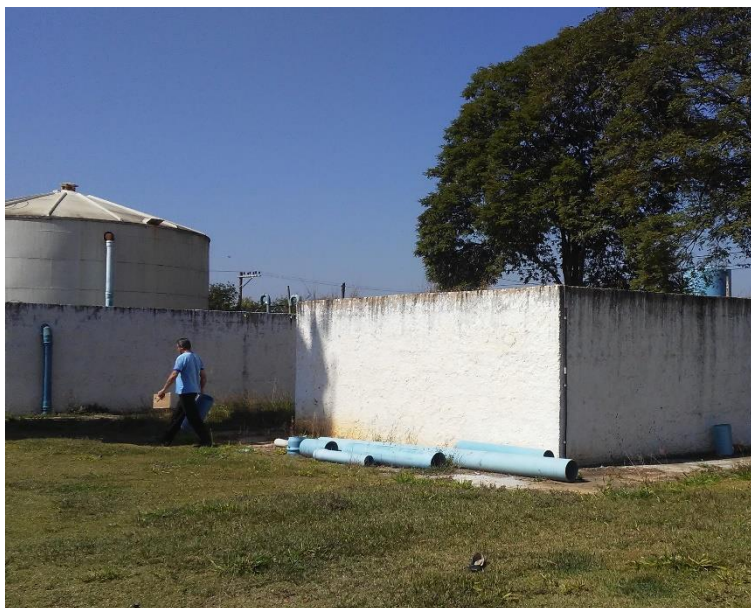
Figura 124 - Reservatórios 200 m 3 cada.
