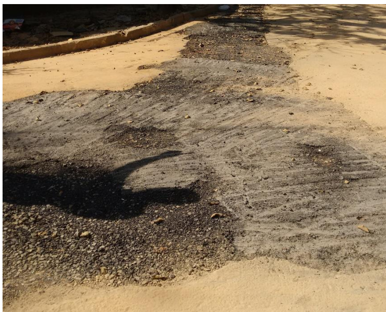
Figura 310 - Construção de sistema de microdrenagem no Jardim Santa Rosa.
