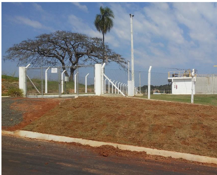
Figura 242 - Entrada ETE Soamim.
