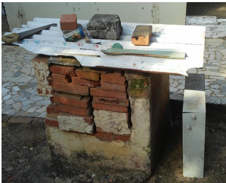
Figura 407 - Poço caipira - Sítios Tupinambás.
