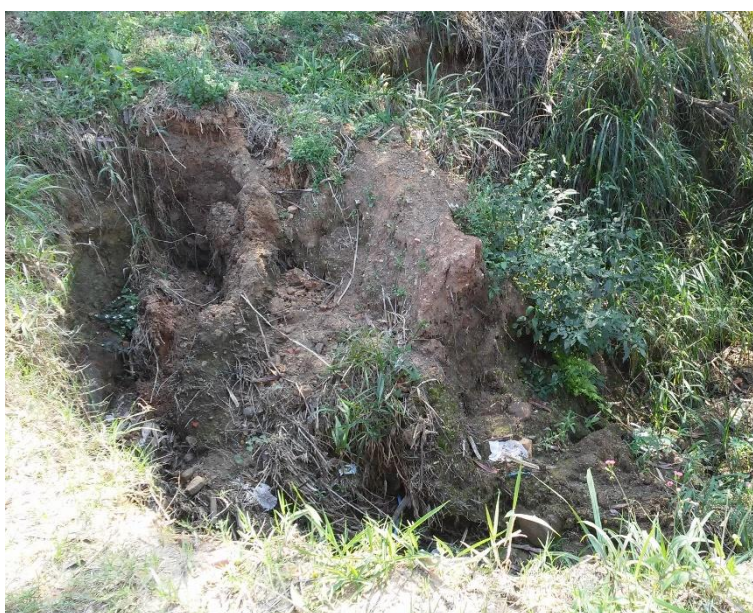
Figura 297 – Erosão do solo devido encaminhamento de águas pluviais - Avenida Mário Covas - Altura nº 1.661.
