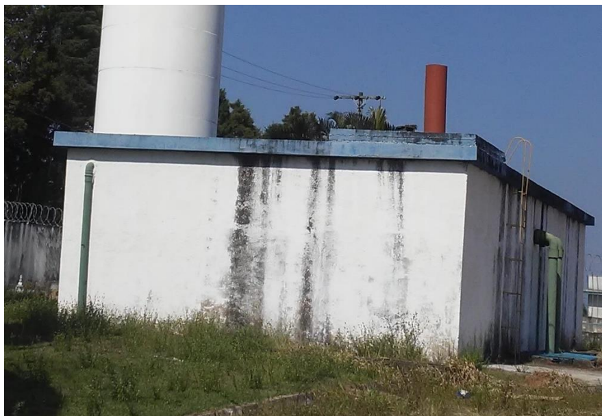
Figura 117 - Reservatório 200 m 3 - desativado e à ser desmobilizado.
