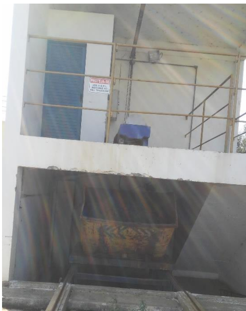
Figura 233 - Caçamba de descarte do lodo.
