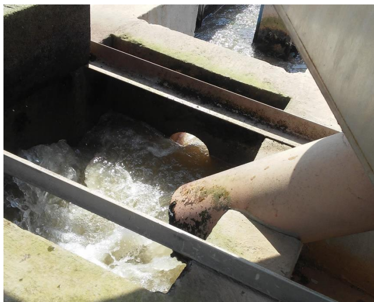
Figura 246 - Saída do esgoto do gradeamento preliminar.
