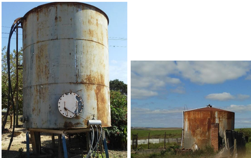
Figura 377 - Reservatórios de água - Fazenda Campo Grande.
