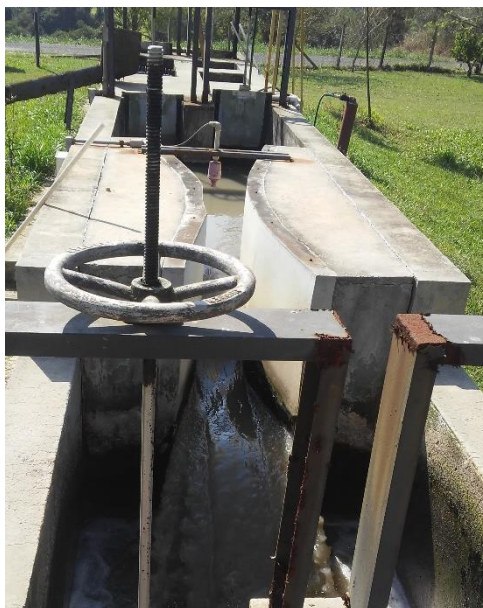
Figura 216 - Calha Parshall – ETE Xyko.
