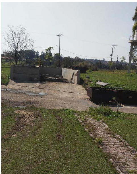
Figura 237 - Vala de secagem e armazenamento de lodo.
