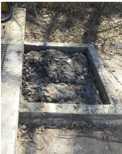
Figura 151 - Secagem de lodo - EEE 04.
