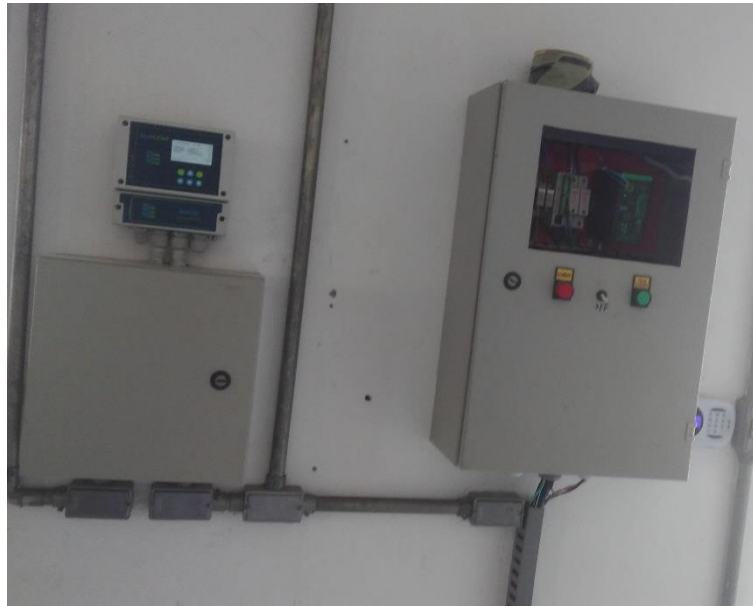
Figura 228 - Dosador automático de hipoclorito de sódio.
