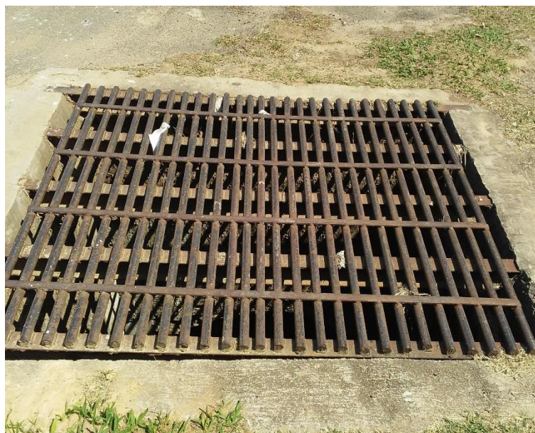
Figura 307 - Galeria construída pelo SAAE - Rua Joaquim Sampaio Sobrinho.
