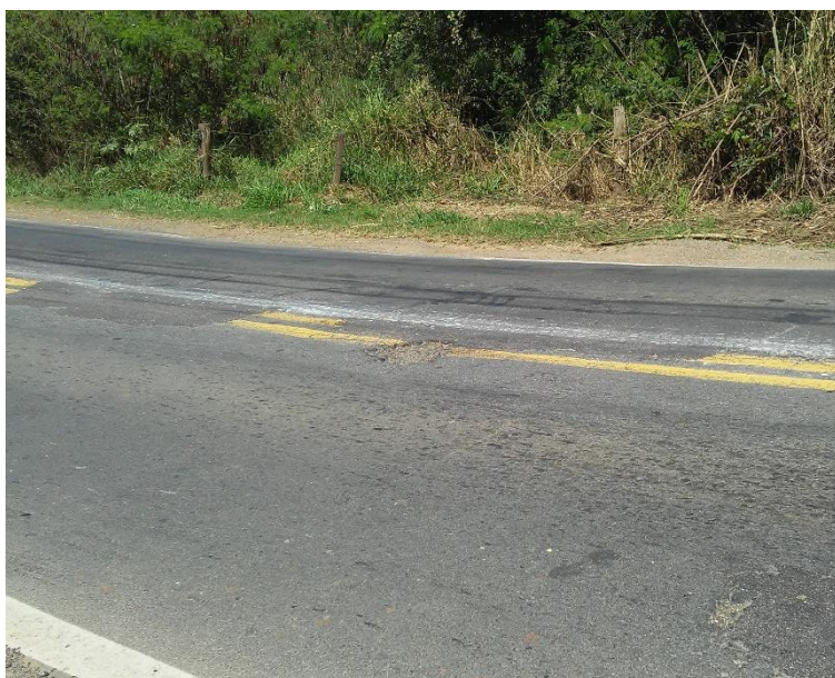
Figura 299 – Ausência de estrutura de drenagem na Avenida Mário Covas - Altura nº 1.661.
