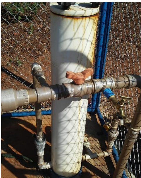
Figura 368 - Dispositivo de cloração - poço da Fazenda Capoava.
