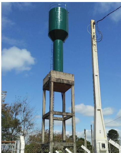
Figura 395 - Reservatório - Agrovila CAIC.
