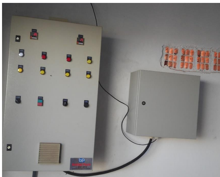
Figura 170 - Painéis de comando EEE Flamboyant.
