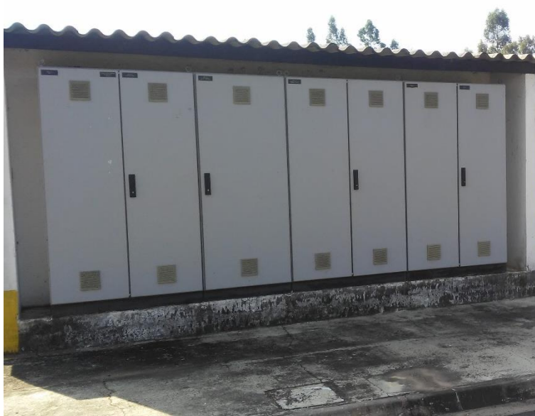
Figura 236 - Painéis de controle das bombas de recirculação de esgoto.
