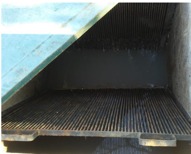
Figura 190 - Gradeamento EEE Portal I.
