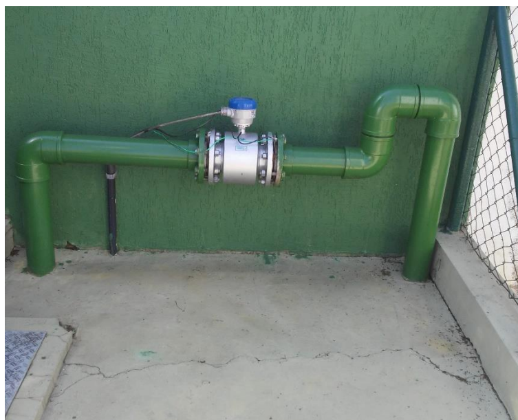
Figura 64 - Macromedidor do Poço 6.
