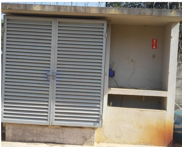
Figura 157 - Abrigo de produtos químicos EEE 08.
