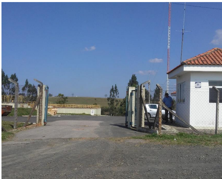
Figura 214 - Guarita - ETE Xyko.
