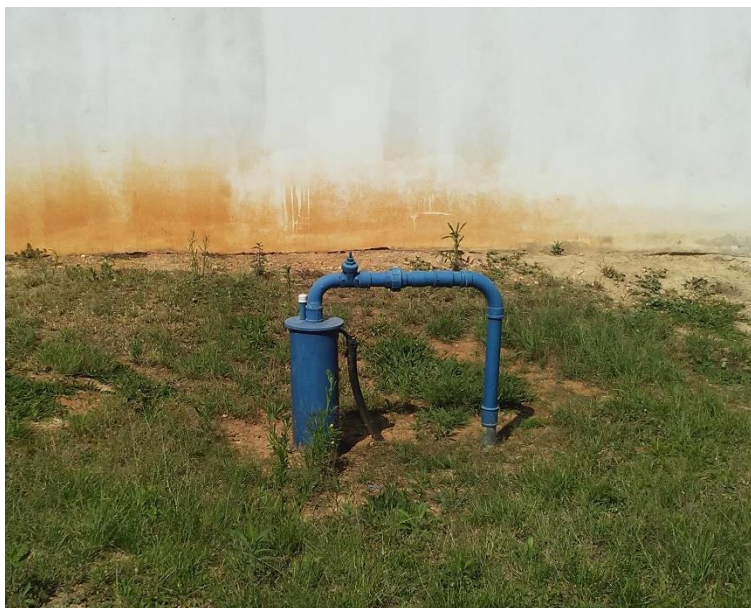
Figura 388 - Poço de uso comum - Valter de Lara.
