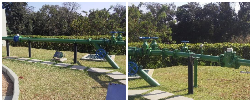
Figura 37 - Tubulação adutora do Poço 1.
