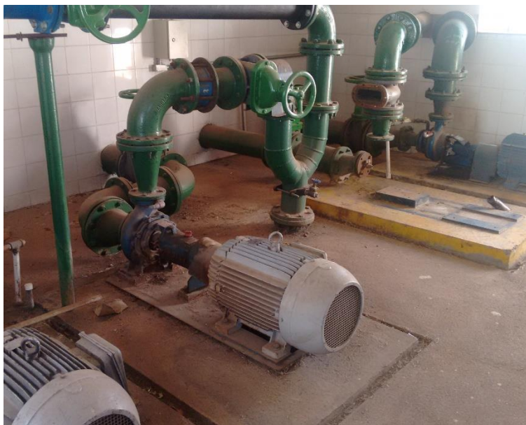
Figura 92 - Conjuntos moto-bomba - EEAT Vila América/Prefeitura.
