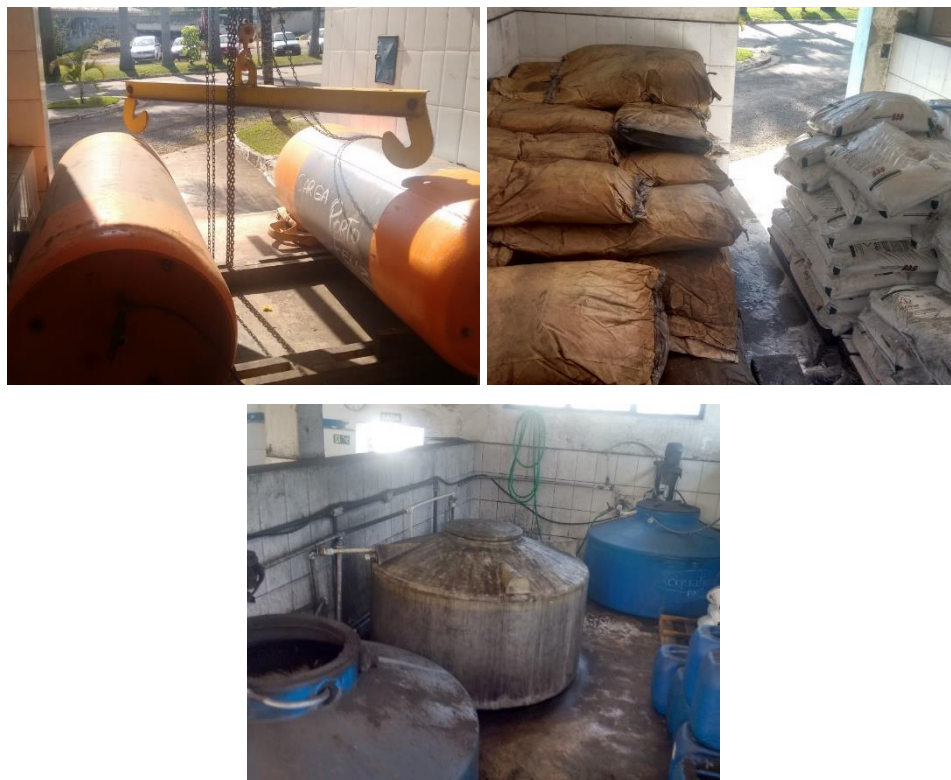
Figura 22 - Armazenamento de produtos químicos.
