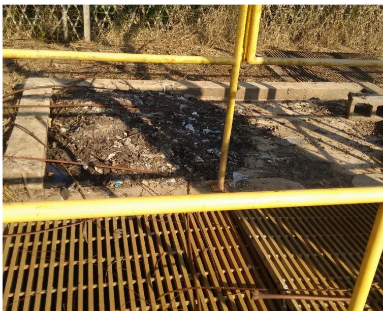
Figura 201 - Secagem de lodo EEE 03.
