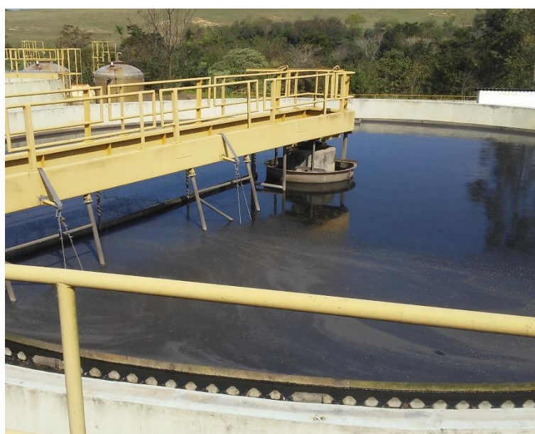
Figura 230 - Módulo de adensamento do lodo.
