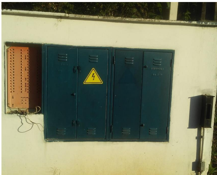
Figura 172 - Pannel elétrico EEE Gruta.
