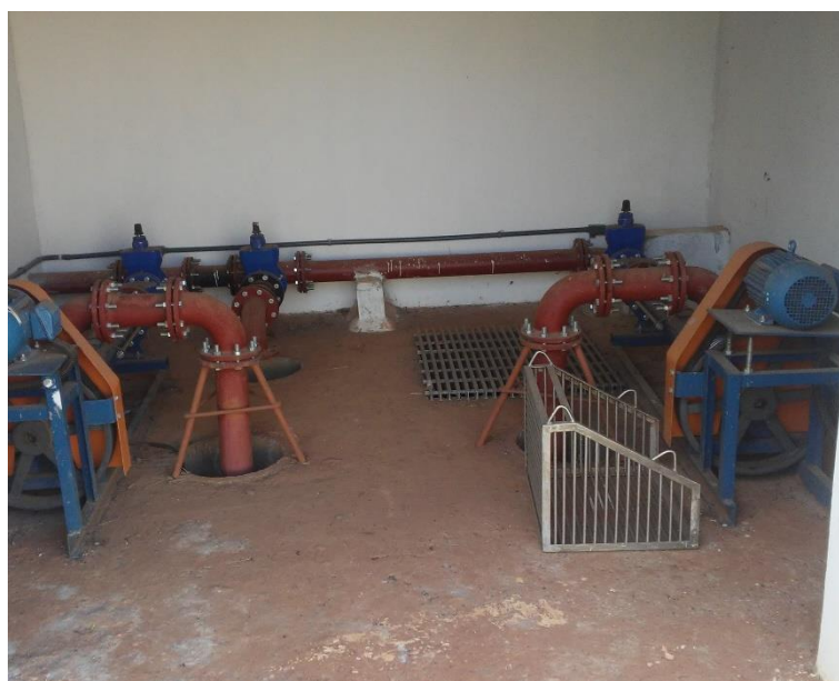
Figura 169 - Conjuntos moto-bomba EEE Flamboyant.
