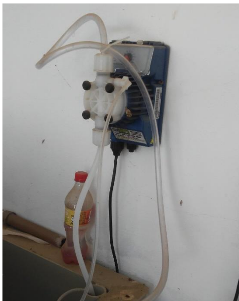
Figura 250 - Dosador de cloro no processo de desidratação.
