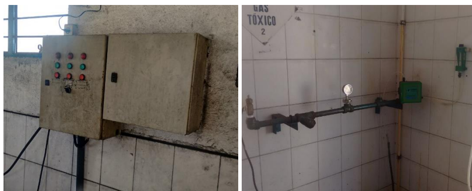
Figura 23 - Painel de Controle - Produtos Químicos.
