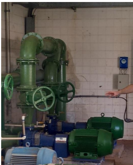
Figura 86 - Conjuntos moto-bomba - EEAT Popular Nova.
