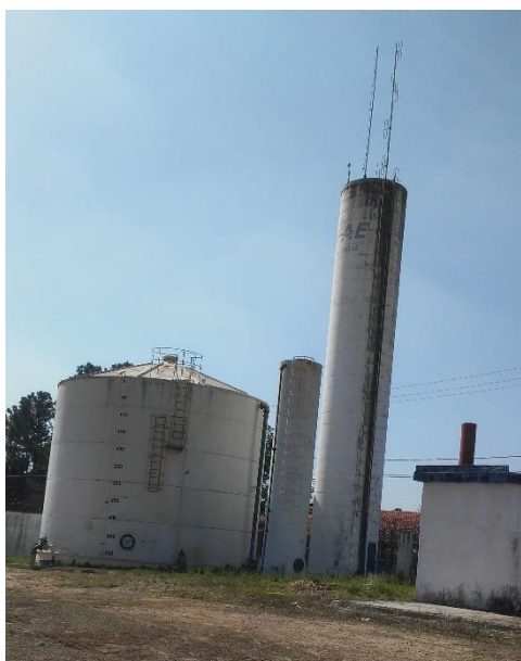
Figura 116 - Reservatórios - da esquerda para direita: 500 m 3 , 60 m 3 e 100 m 3 .
