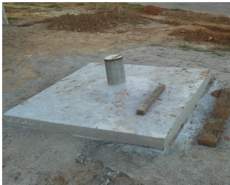
Figura 76 - Poço São Francisco.
