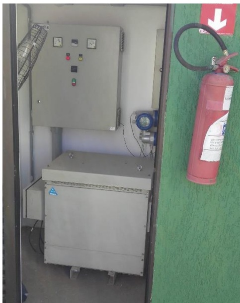
Figura 63 - Painel de controle do Poço 6.
