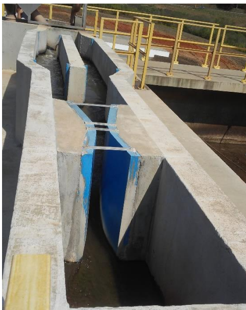
Figura 247 - Calha parshall e caixa de areia- ETE Soamim.
