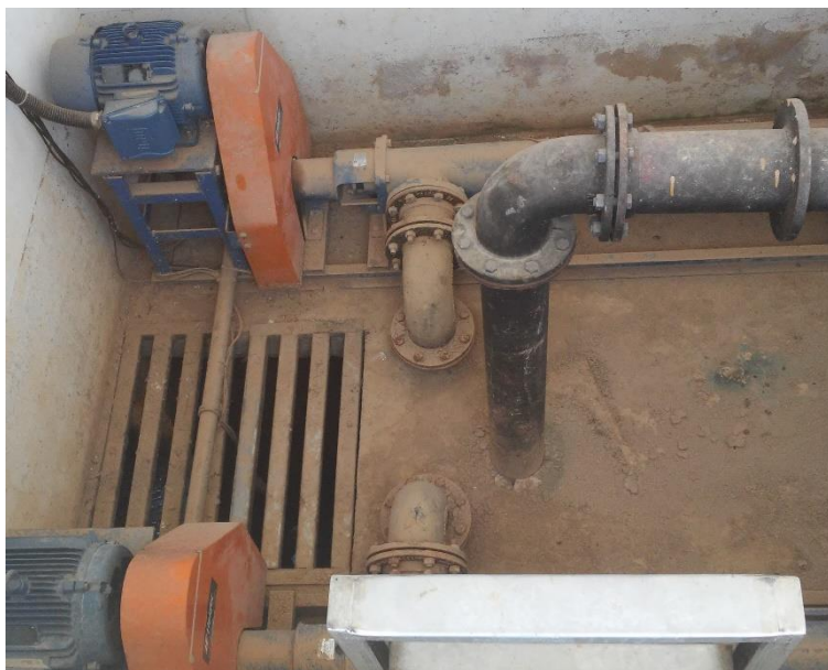
Figura 178 - Conjuntos moto-bomba EEE Olívio Barbosa.
