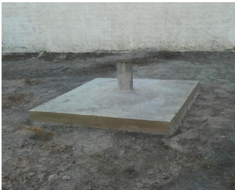
Figura 78 - Poço Stand Pipe.
