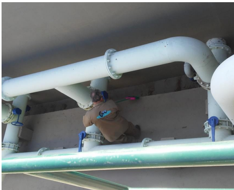
Figura 32 - Tubulação de saída dos filtros.
