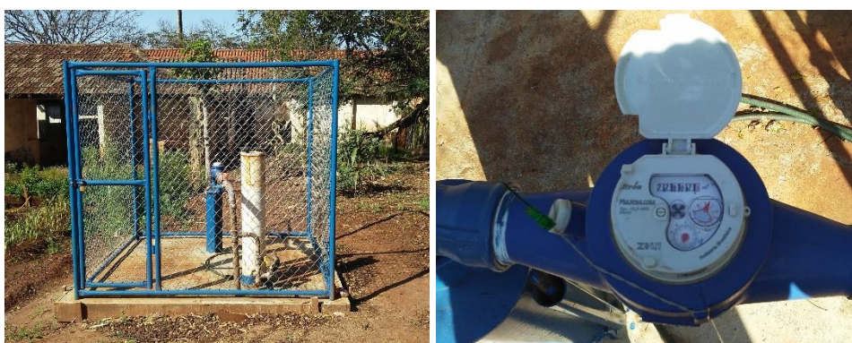
Figura 367 – Poço tubular profundo - Fazenda Capoava.
