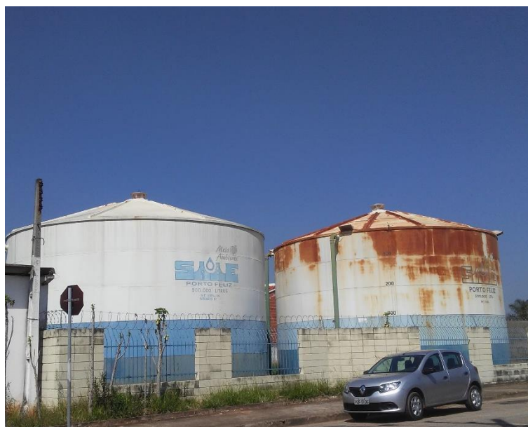
Figura 126 - Reservatórios 500 m 3 cada.
