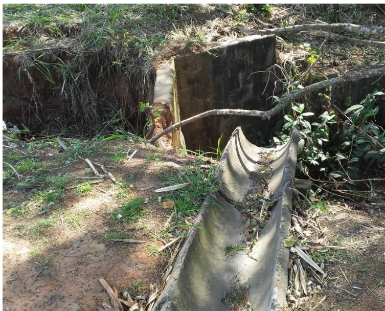
Figura 321 - Travessia na Avenida Mário Covas - Rotatória Gerson Angilieri.
