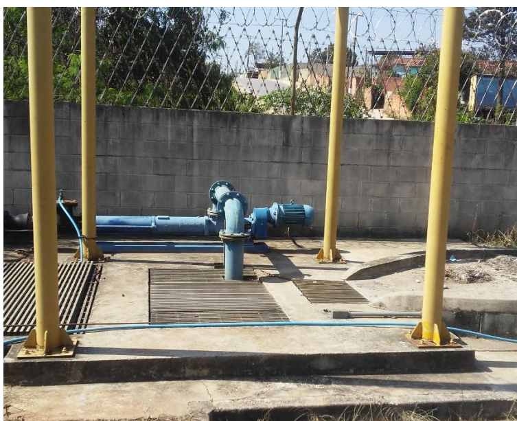
Figura 159 - Conjunto moto-bomba EEE 08.
