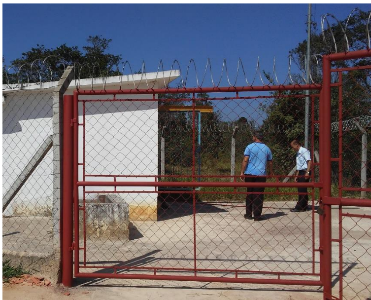
Figura 174 - Entrada EEE Olívio Barbosa.
