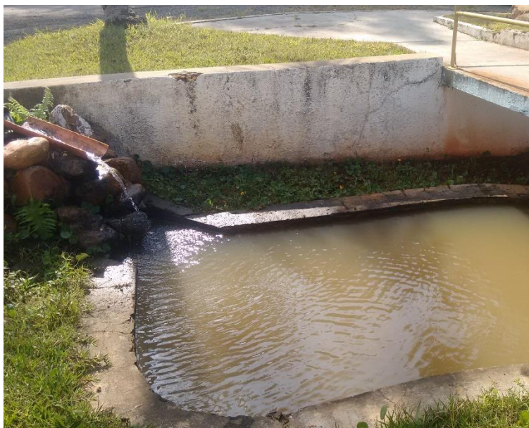
Figura 25 - Desvio de água do Ribeirão Avecuia.
