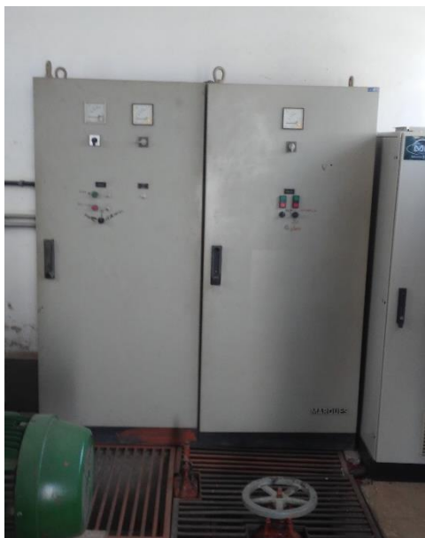
Figura 100 - Pannel de controle - EEAT Vila América.
