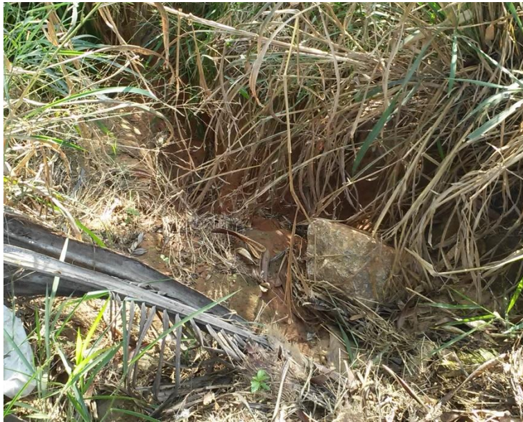
Figura 291 - Erosão de solo devido águas pluviais - Avenida Mário Covas - Altura nº 1.059.
