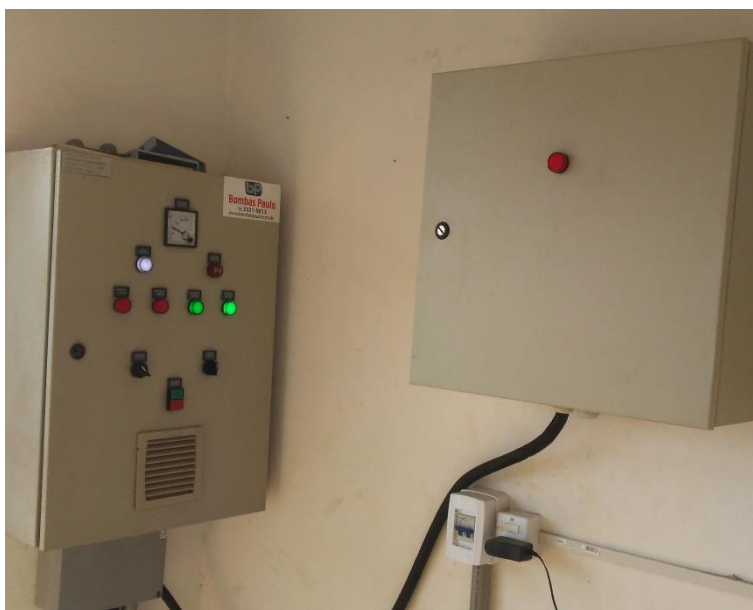
Figura 184 - Painéis de comando EEE Portal dos Bandeirantes II.
