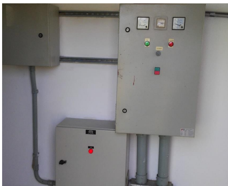
Figura 54 - Painel de controle Poço 4.
