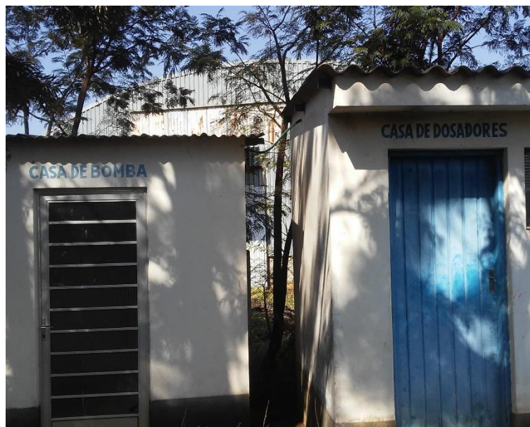
Figura 69 - Infraestrutura do Poço do Distrito Industrial Itaquí.
