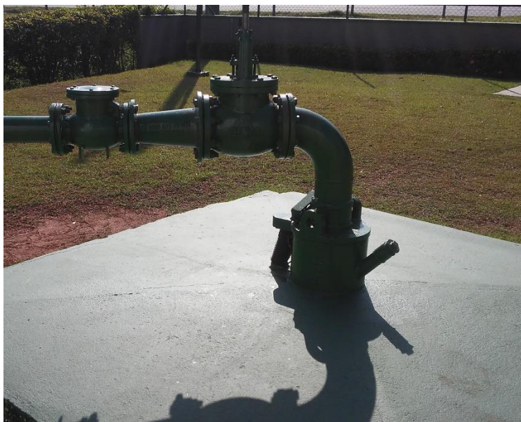
Figura 36 - Poço tubular profundo 1.
