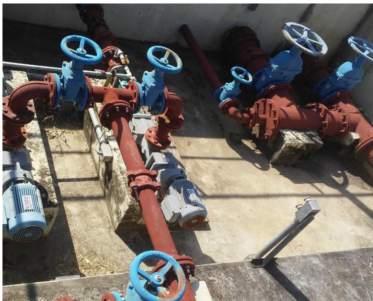
Figura 235 - Tubulação de recirculação do esgoto tratado.
