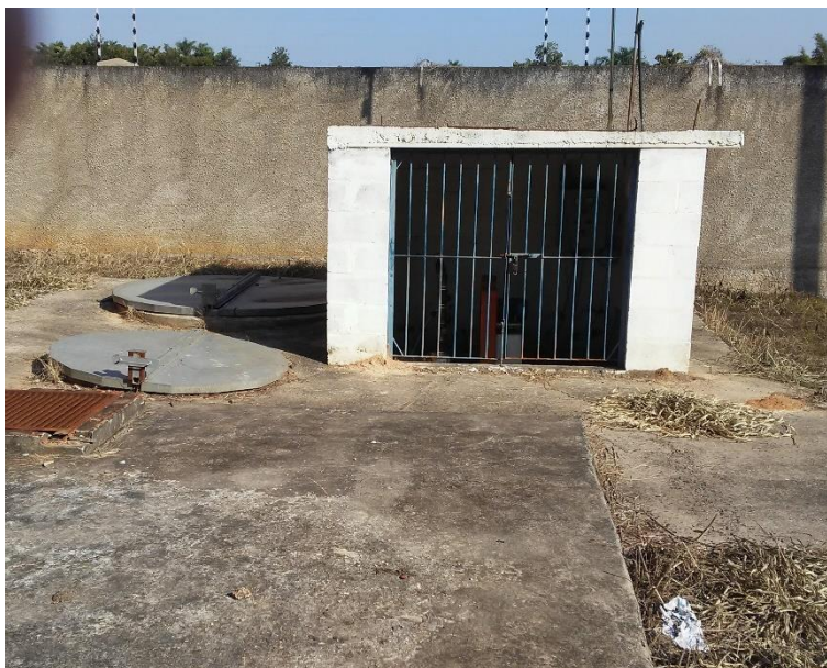
Figura 139 - Abrigo de bomba.
